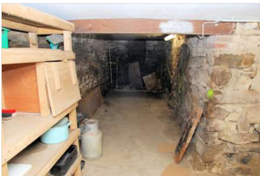
Foto 30 Geiningen 31, Kellergeschoss, Raum unter dem Schlafzimmer
