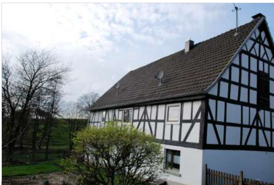
Foto 4 Geiningen 31, Straßenseite (Osten) und Südseite
