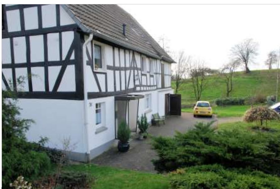
Foto 3 Geiningen 31, Straßenseite (Osten) und Nordseite mit Hauseingang
