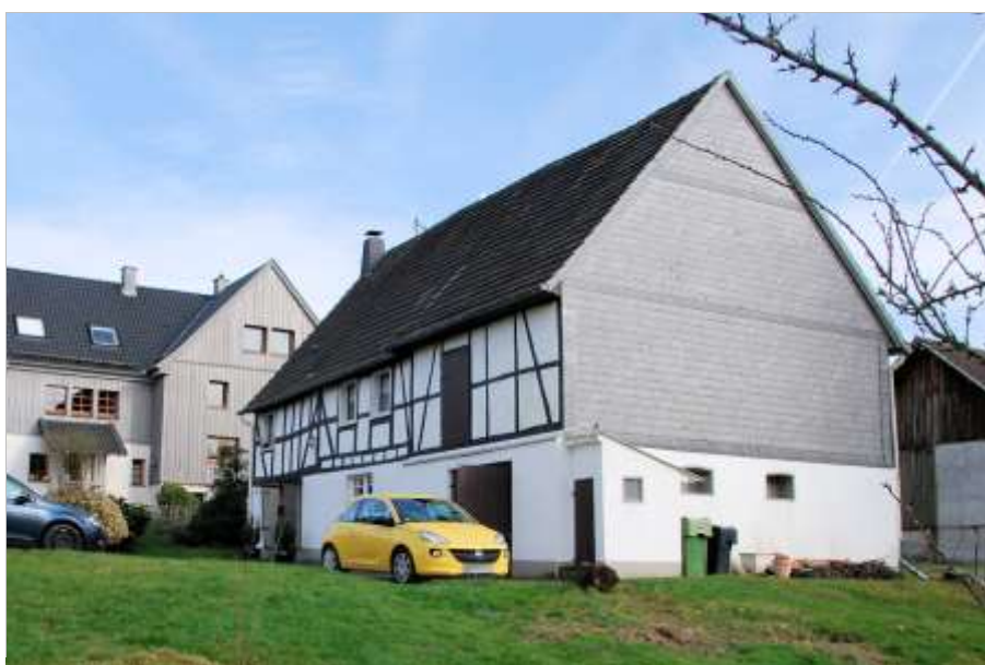
Foto 2 Geiningen 31, Westseite und Nordseite mit Hauseingang
