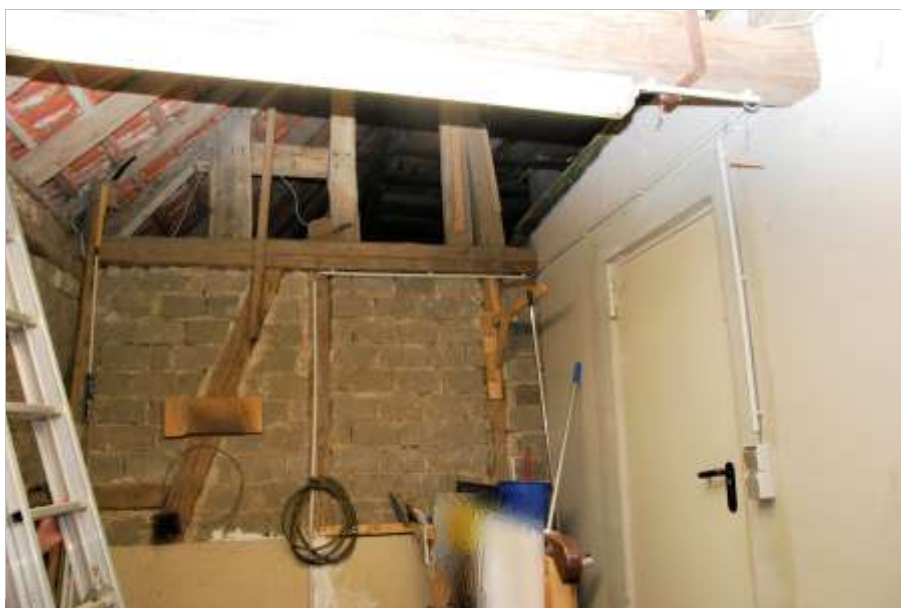
Foto 34 Geiningen 31, Raum über der Garage, rechts Tür zur Wohnung im Obergeschoss
