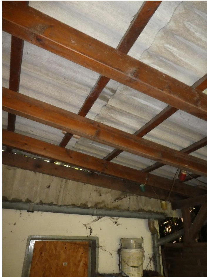
Abbildung 2: Ansicht der Dacheindeckung von unten.
