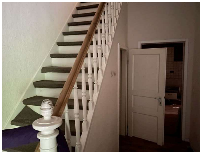
Treppe zum Dachgeschoss im Altbau
