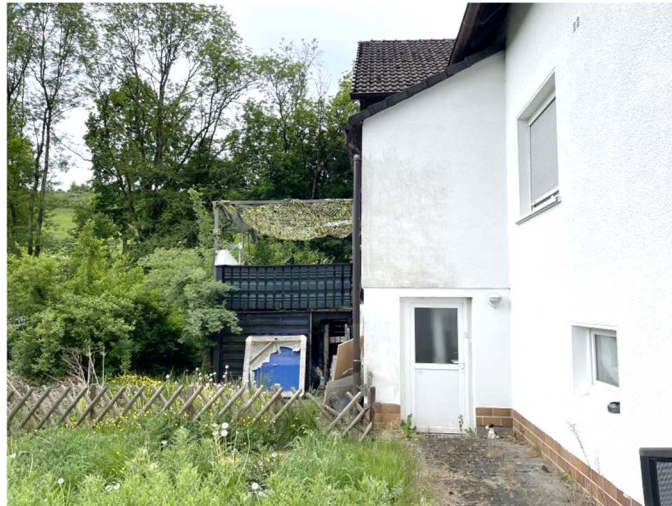
Hauseingang im Vorbau des Anbaus
