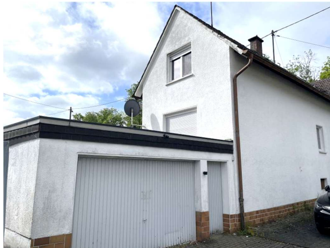
Pkw-Garage am Anbau
