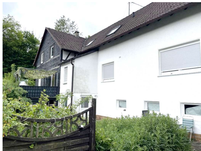
Südostansicht Altbau und Anbau mit Vorbau
