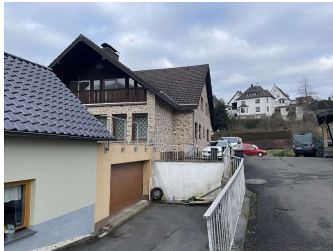
Rampe zum Garagenanbau
