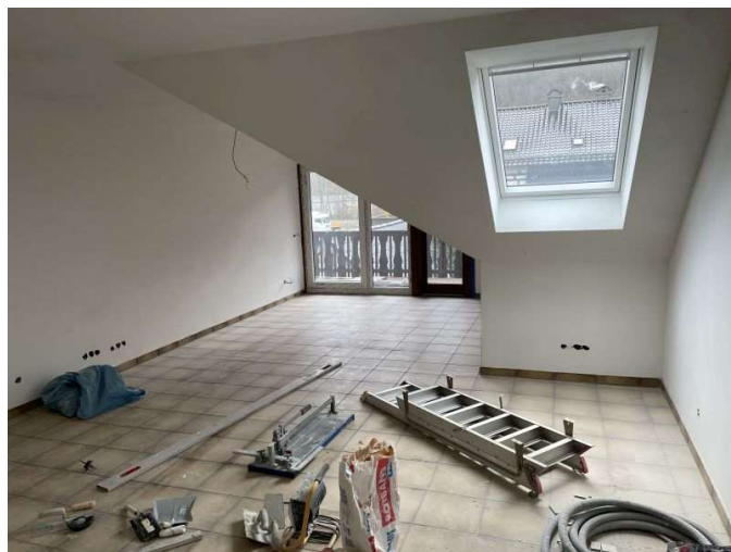
Wohnung im Dachgeschoss rechts
