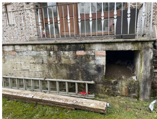
Unterkellerung des Hauseingangspodests
