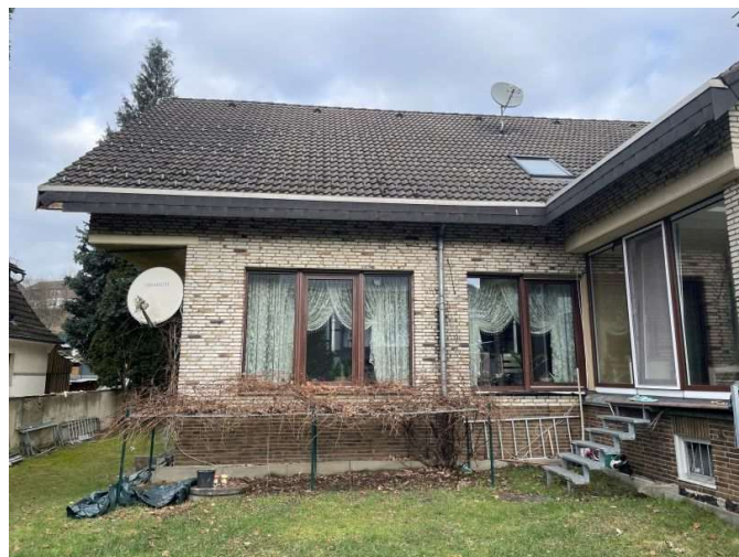
Südansicht mit Treppe vom Wintergarten zum Garten
