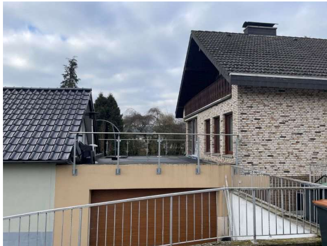
Garagenanbau mit Dachterrasse
