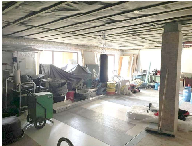
Ehemaliges Schwimmbad im Kellergeschoss
