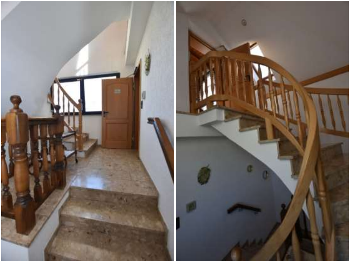
Angebautes Treppenhaus - Westseite
