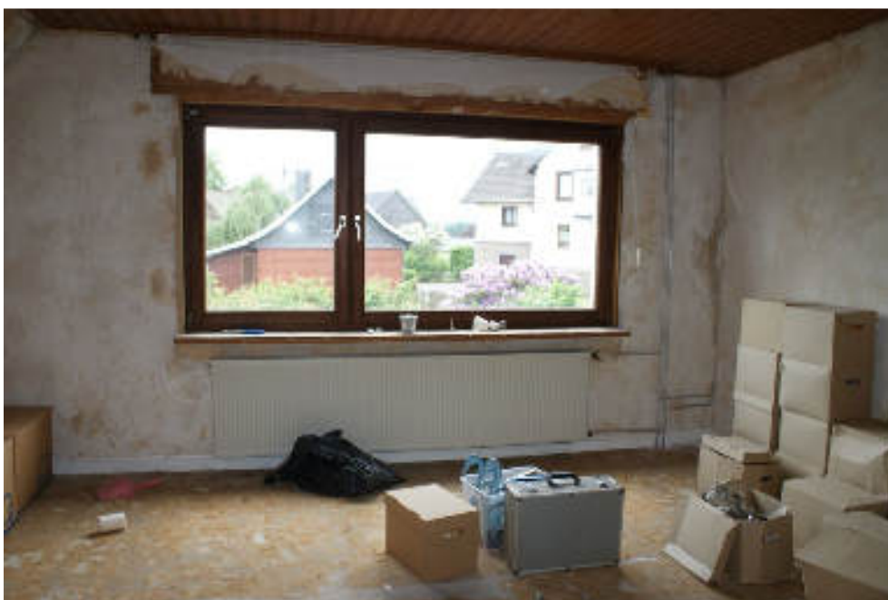
Bild 44 Raum OG im ehem. Stallanbau mit Fenster im Südgiebel
