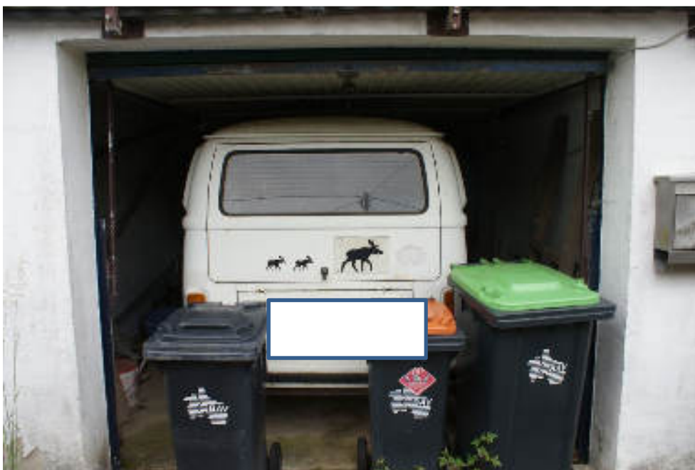
Bild 15 An der Nordseite angebaute Massivgarage / früher Schuppen
