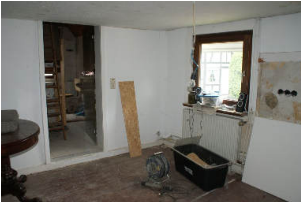
Bild 45 Zimmer OG frontseitig / gefangenes Bad OG
