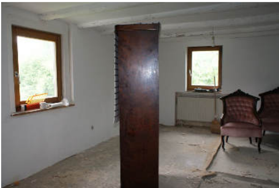
Bild 40 Raum OG im Anbau
