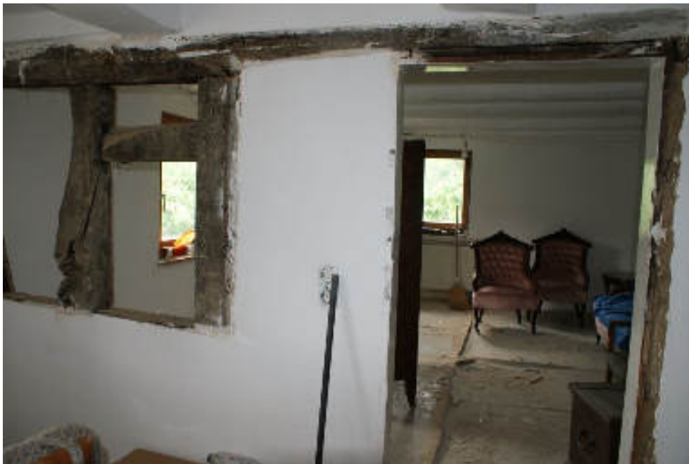
Bild 39 Angrenzender Anbau OG/ Detail alte Außenwand Fachwerk
