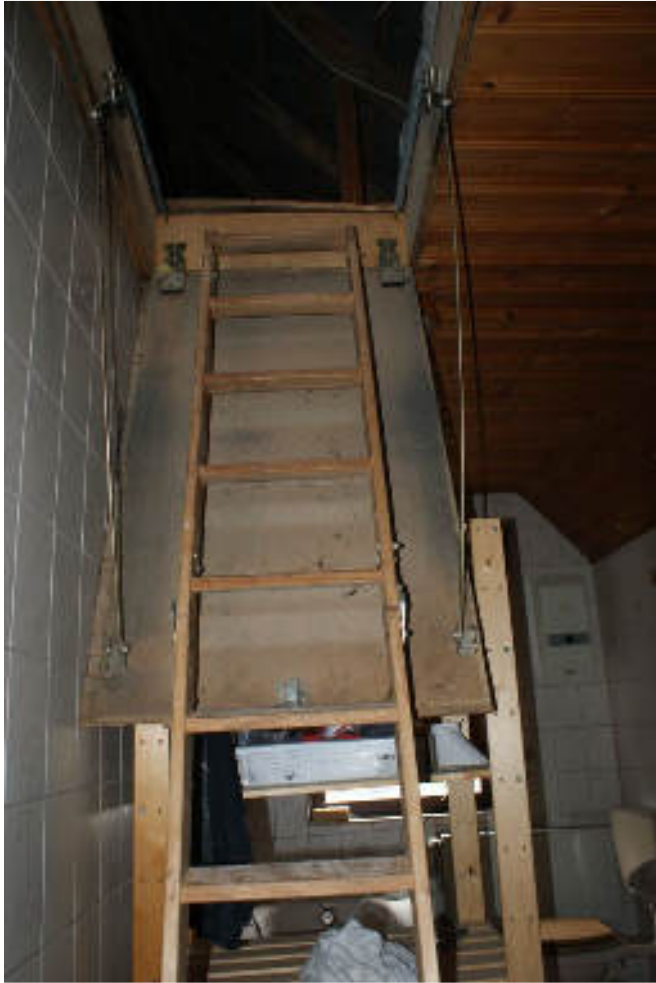
Bild 49 Einschubtreppe im Bad zum Dachboden
