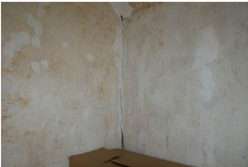
Bild 86 Riss in der Ecke im OG ehem. Stallanbau
