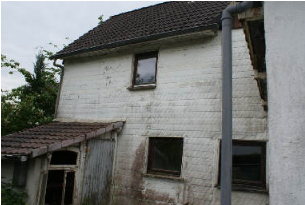
Bild 13 Blick auf Anbau und Innenhof hinter der Garage
