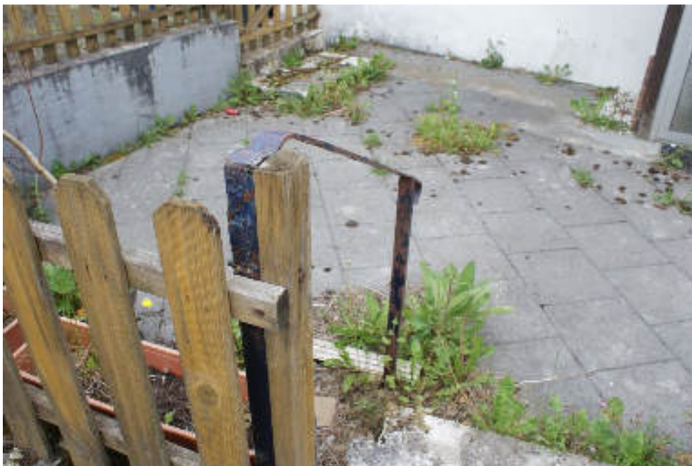
Bild 18 Treppe mit drei Stufen von der Straße als Zugang
