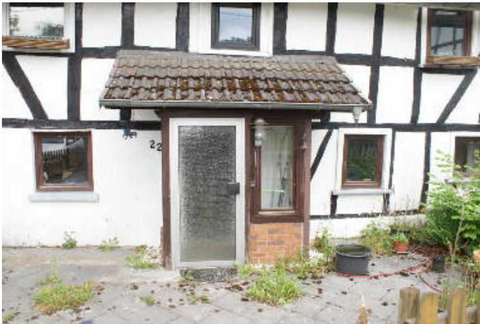
Bild 19 Hauseingang mit vorgesetztem, einfachstem Windfang
