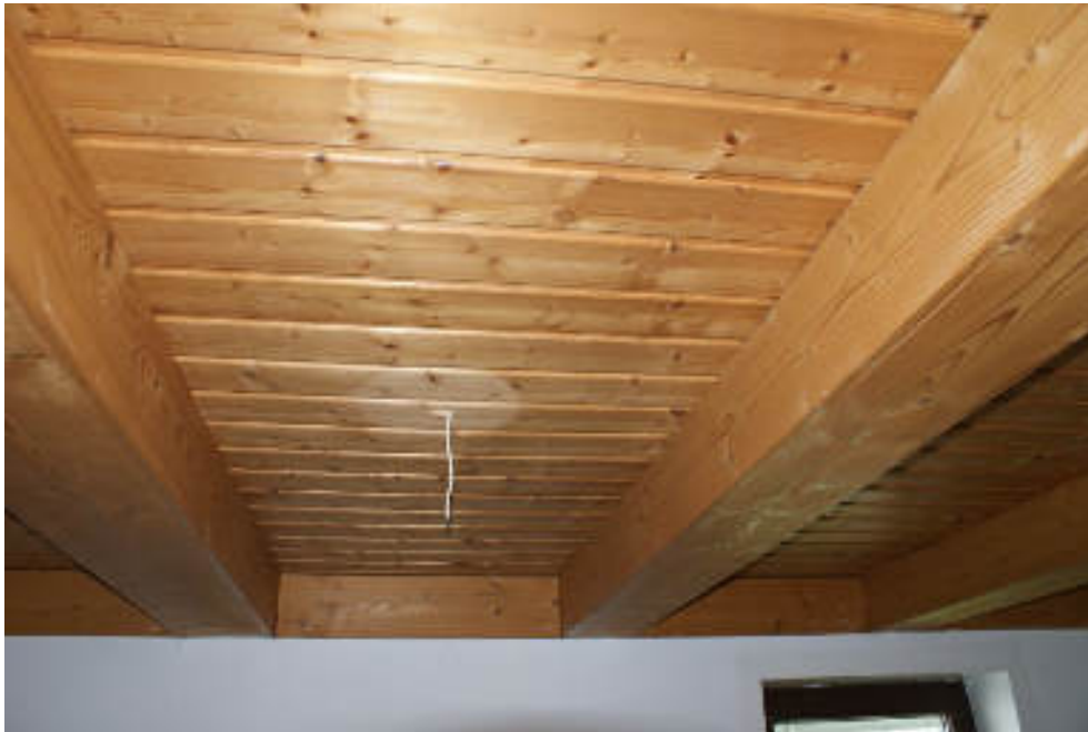
Bild 43 Detail Holzdecke OG
