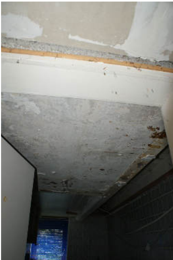
Bild 77 Stark schadhafte Decke Bad EG mit Wasserschaden
