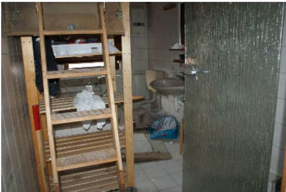
Bild 46 Blick in das Bad OG
