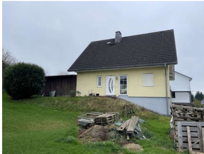
Einfamilienhaus Knappenstr. 44 - Ostansicht mit Hauseingang
