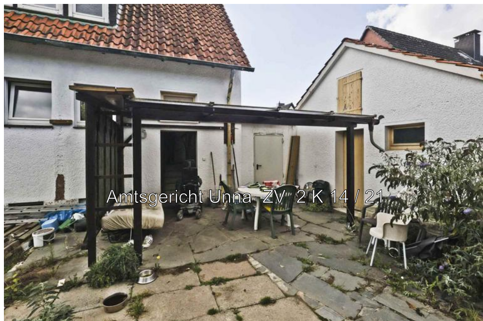
Foto Nr. 2 Terrasse
