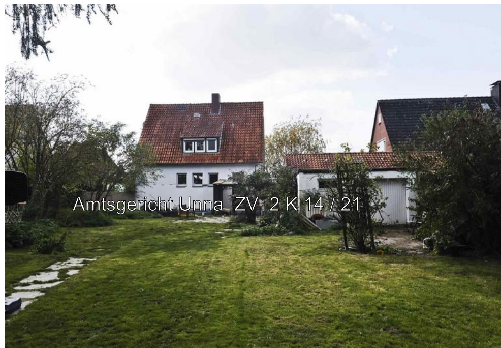
Foto Nr. 2 Gartenansicht
