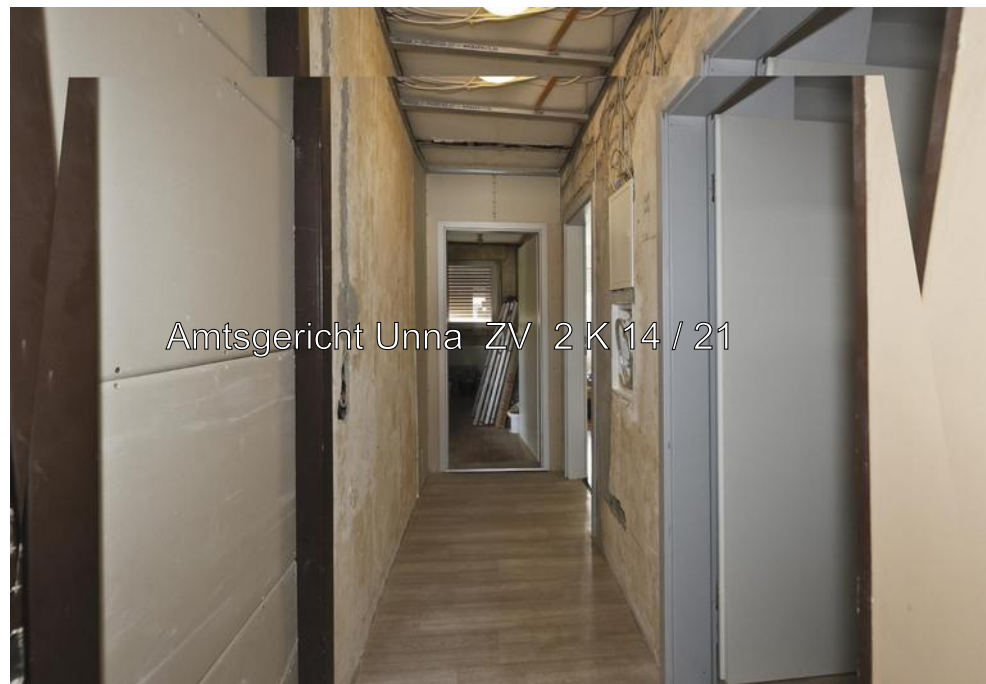
Foto Nr. 4 DG: Flur
