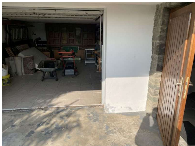
Kellergarage unter dem Wintergartenanbau
