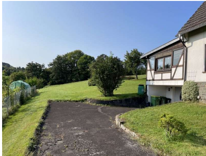
Zufahrt zur Kellergarage unter dem Wintergartenanbau
