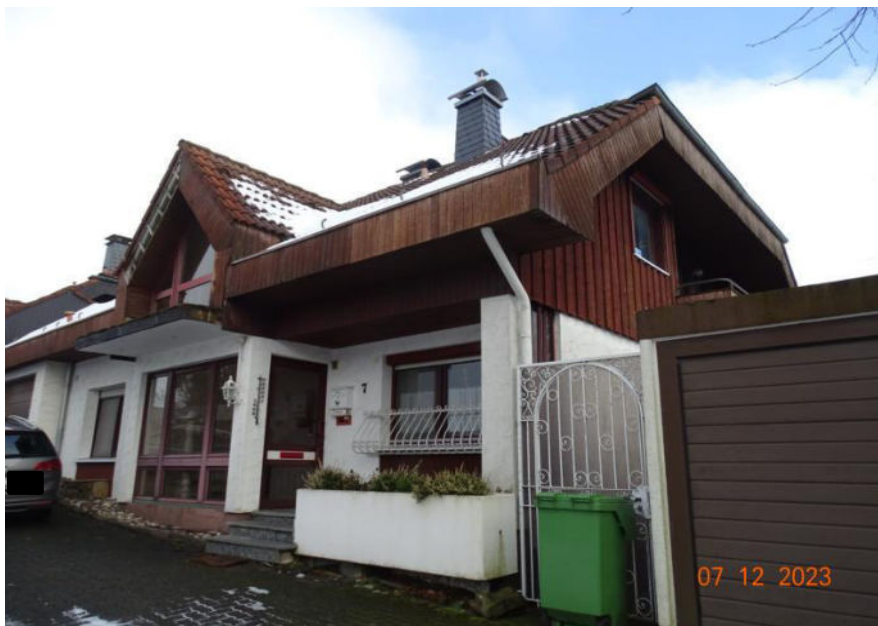
Objektansicht von Süd-West
