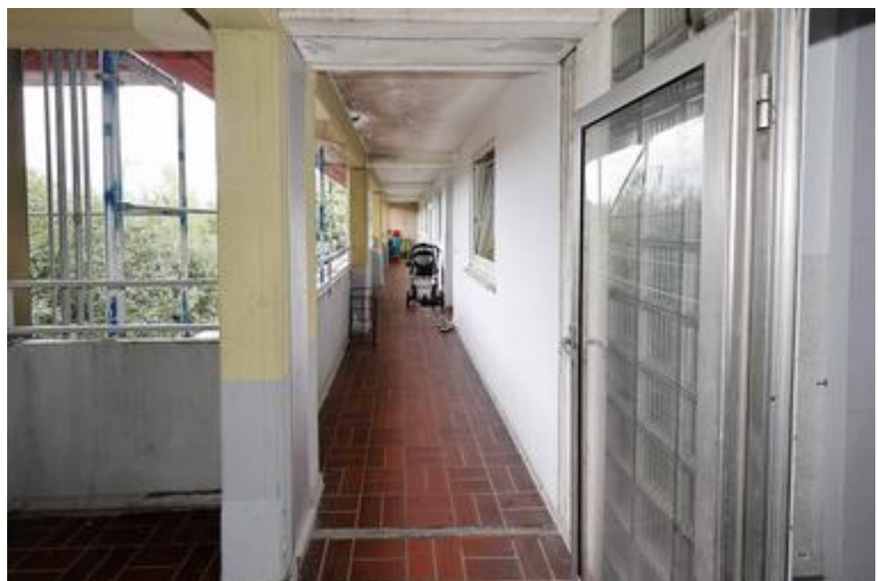
Foto Nr. 6 3.OG: Laubengang
