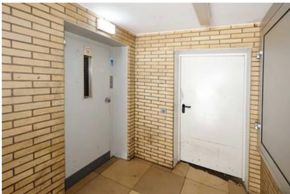
Foto Nr. 4 Eingangsgeschoss mit Zugang zum Aufzug und Treppenhaus
