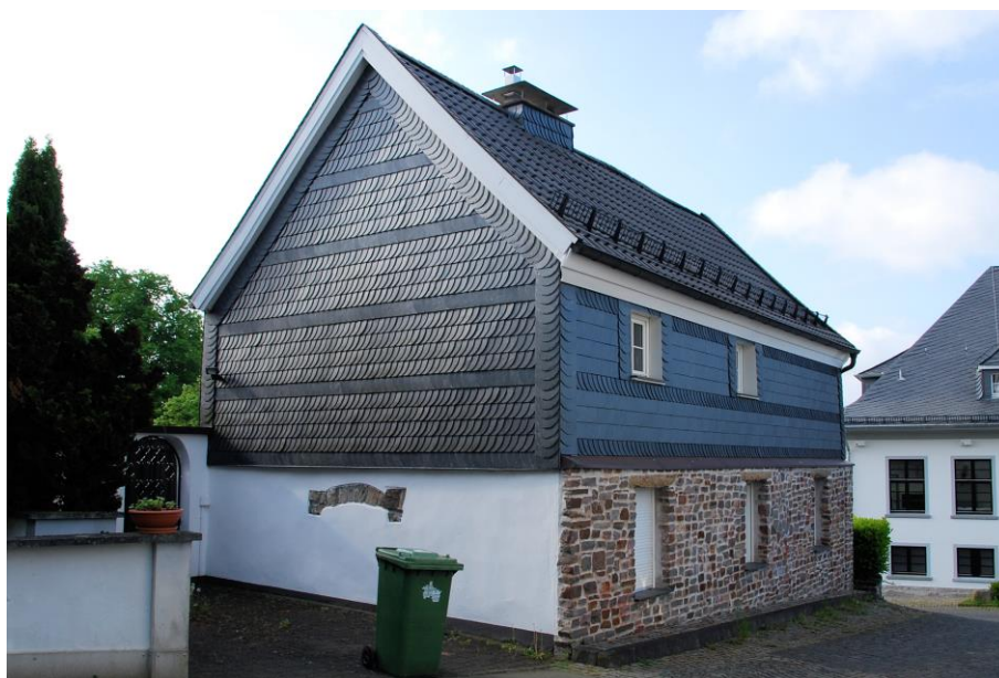
Foto 5 Höherweg 2, Nordgiebel, Stellplatz und Westseite
