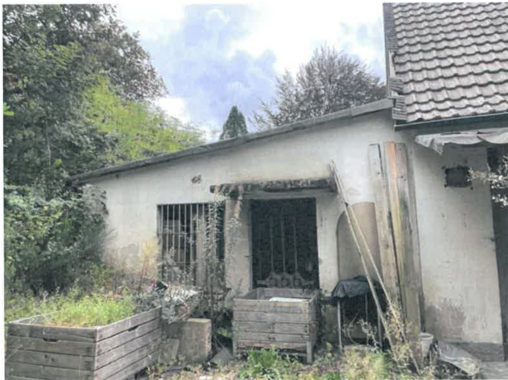
Anbau Betrieb (Gebäude 3)
