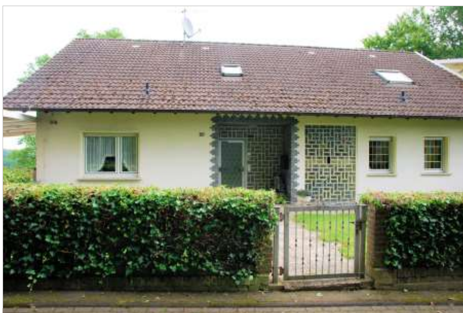
Foto 2 Ritterseifener Weg 30, Straßenseite mit Hauingang
