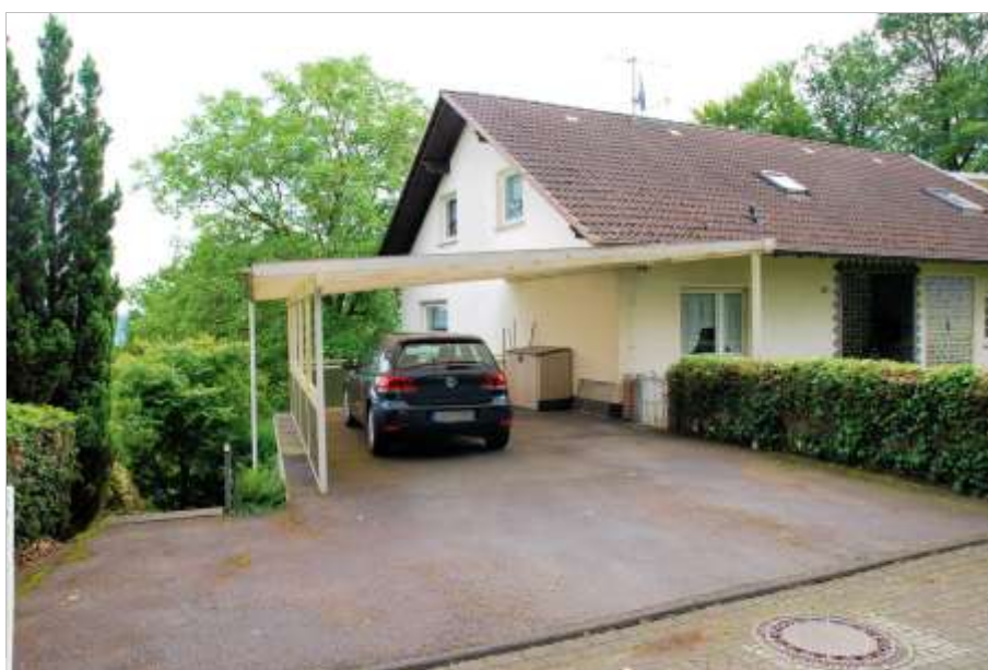
Foto 3 Ritterseifener Weg 30, Straßenseite mit Carport
