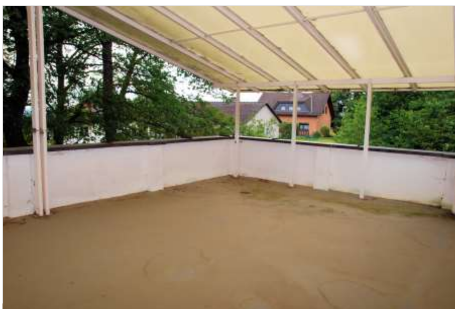
Foto 37 Ritterseifener Weg 30, Dachgeschoss, Terrasse
