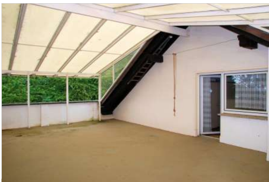
Foto 36 Ritterseifener Weg 30, Dachgeschoss, Terrasse
