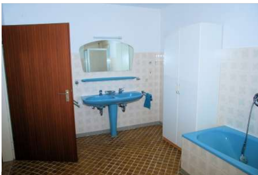
Foto 25 Ritterseifener Weg 30, Erdgeschoss, Bad
