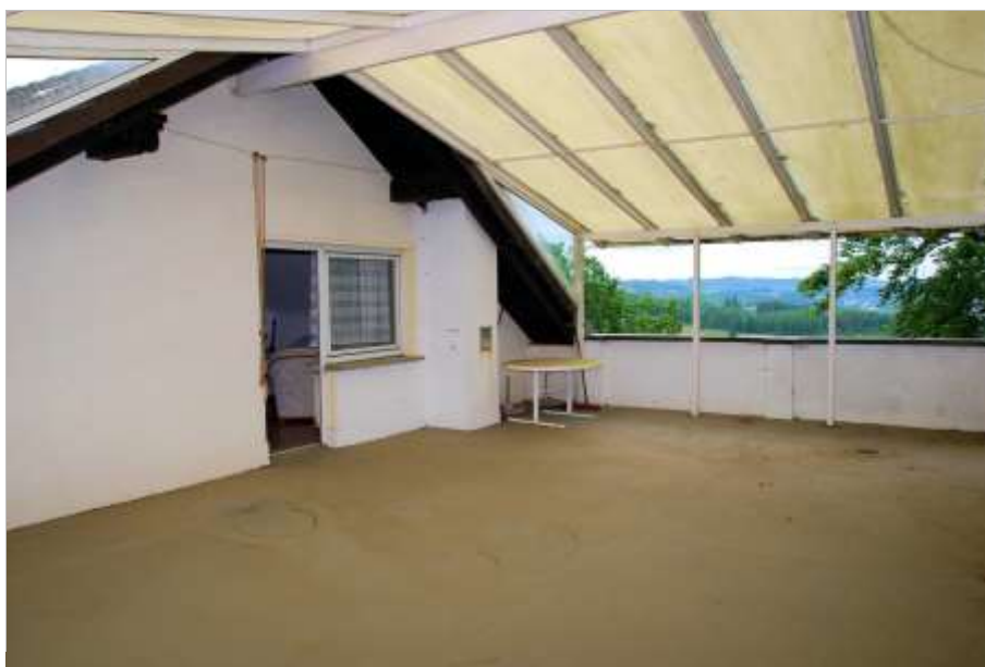
Foto 35 Ritterseifener Weg 30, Dachgeschoss, Terrasse
