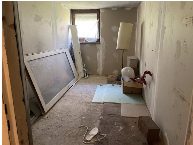
Wohnung im Kellergeschoss
