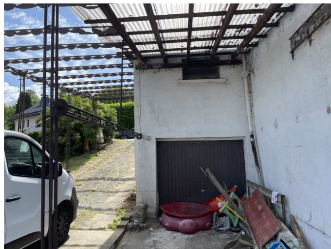
Rückwärtige Ansicht Garagenanbau
