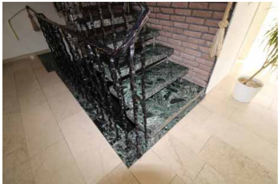
Ehemalige Treppe zum Dachgeschoss
