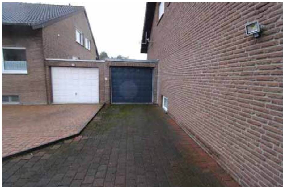
Sicht auf die Pkw- Garage des zu bewertenden Objekts
