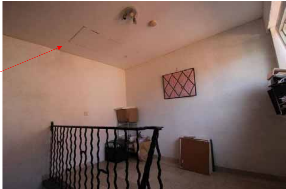
Bodeneinschubtreppe zum Spitzboden
