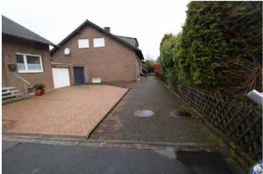
Sicht von der Straße aus auf die Zufahrt und die linke Giebel- seite des zu bewertenden Objekts
