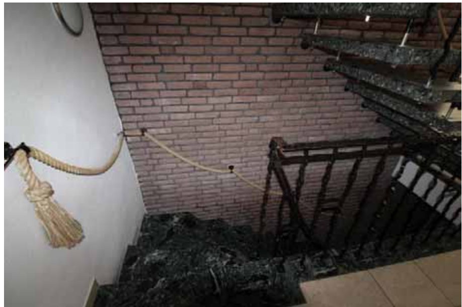
Treppe zum Kellergeschoss
