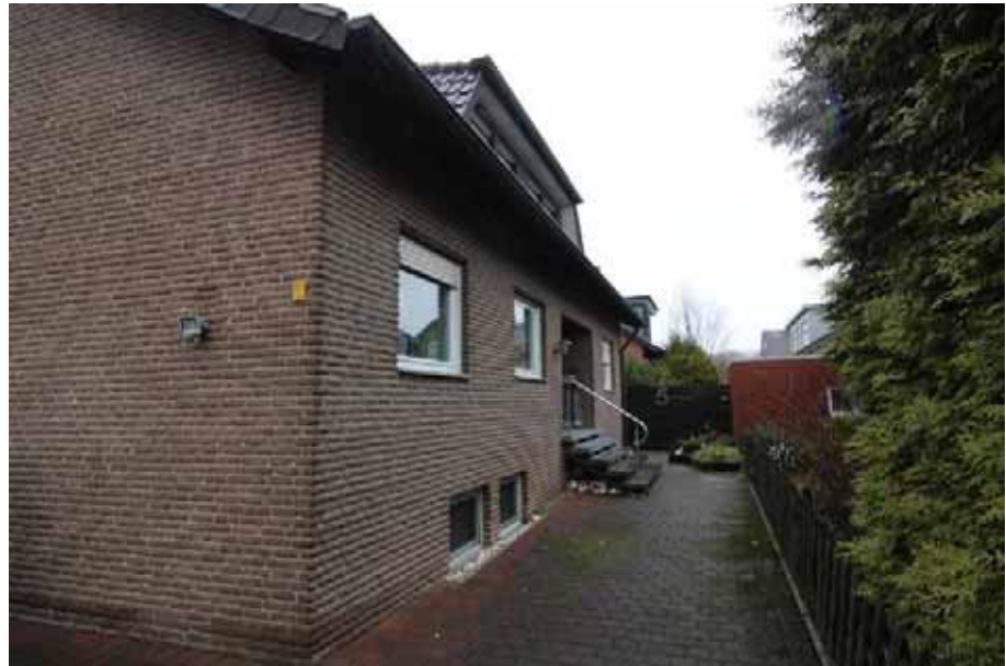
Sicht auf die Zuwegung und Vorderseite des zu bewertenden Objekts
