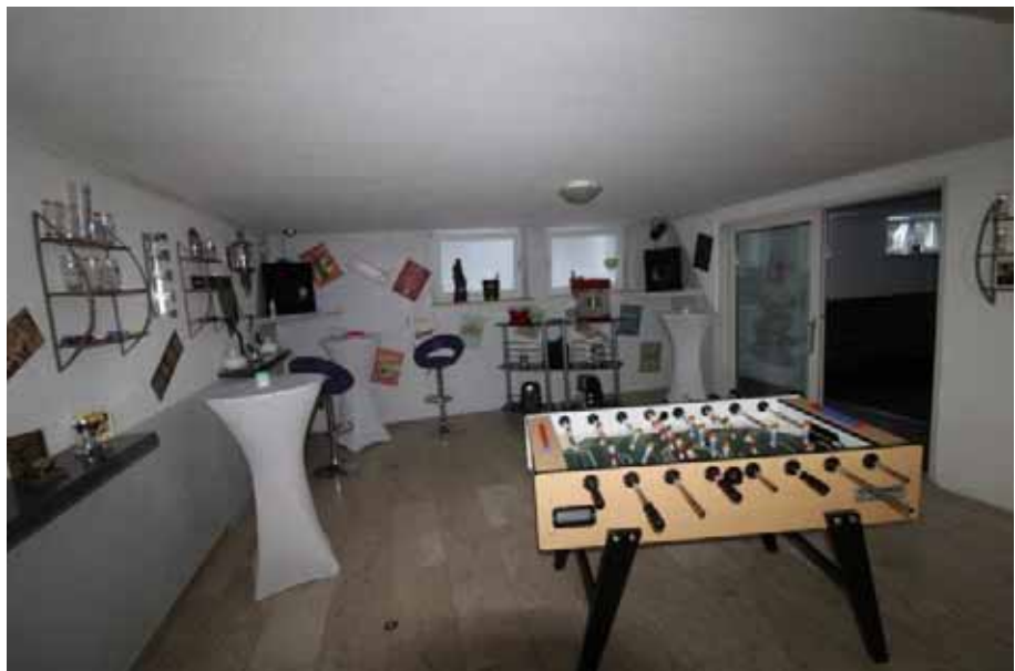
Hobbyraum, im Wandbereich links der Fenster befinden sich Feuchtigkeitsflecken
