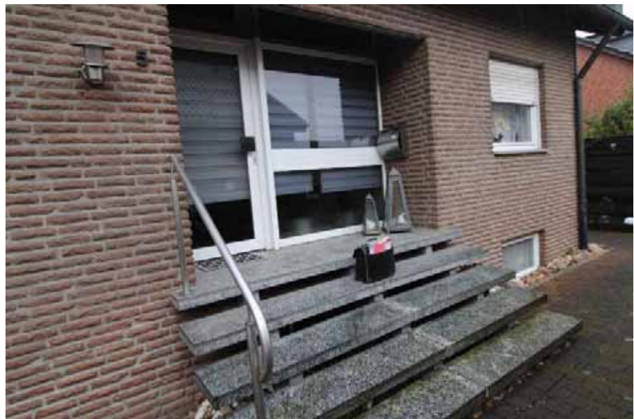
Sicht auf den Eingangsbereich an der Vorderseite des zu bewertenden Objekts
