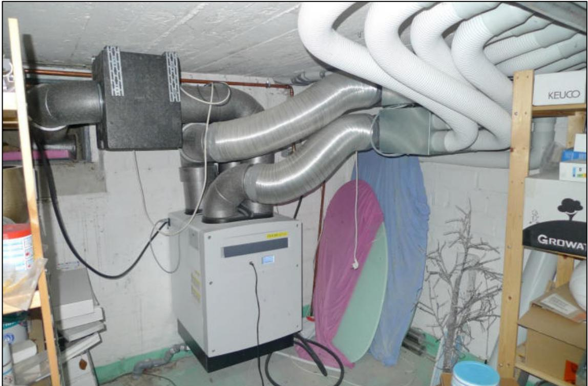
Abbildung 16 Lüftungsanlage im Kellergeschoß vom Zweifamilienhaus
