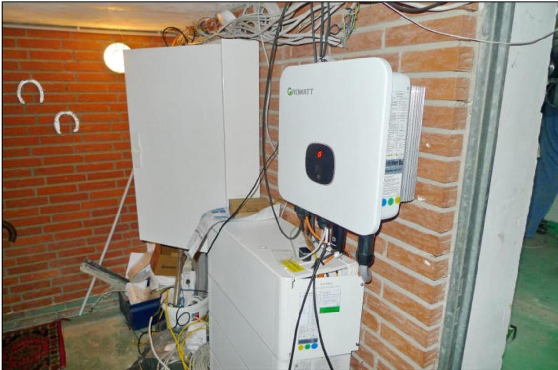
Abbildung 17 Wechselrichter der Photovoltaikanlage im Kellergeschoss vom Zweifamilienhaus auf dem zu bewertenden Grundstück fotografiert am 31.10.2023
