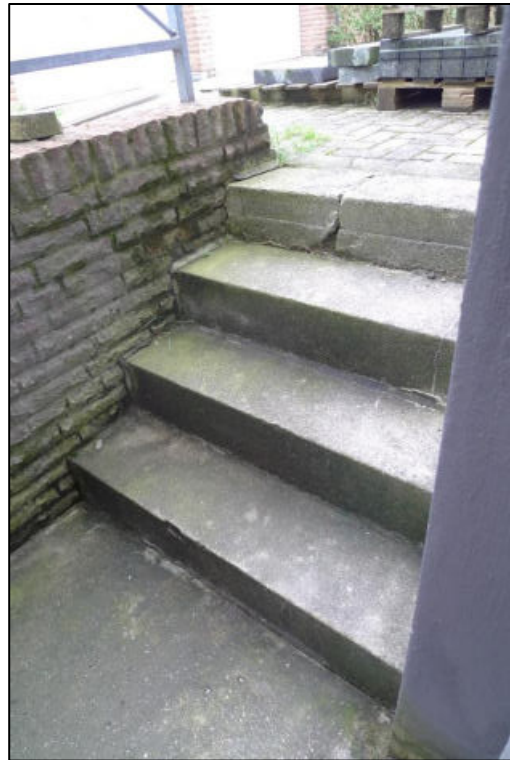
Abbildung 41 Kelleraußentreppe auf dem zu bewertenden Grundstück fotografiert am 06.07.2023
