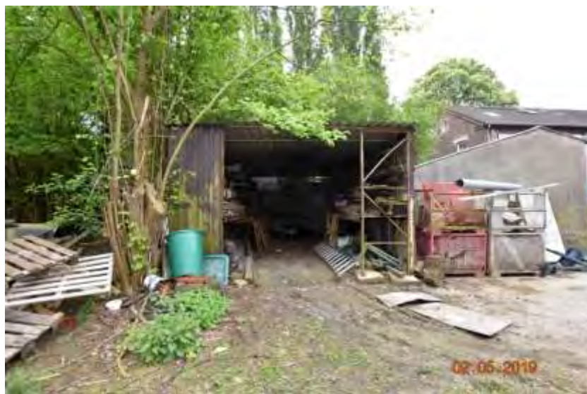
Überdachung hinter dem Bauteil 7- wertlos
