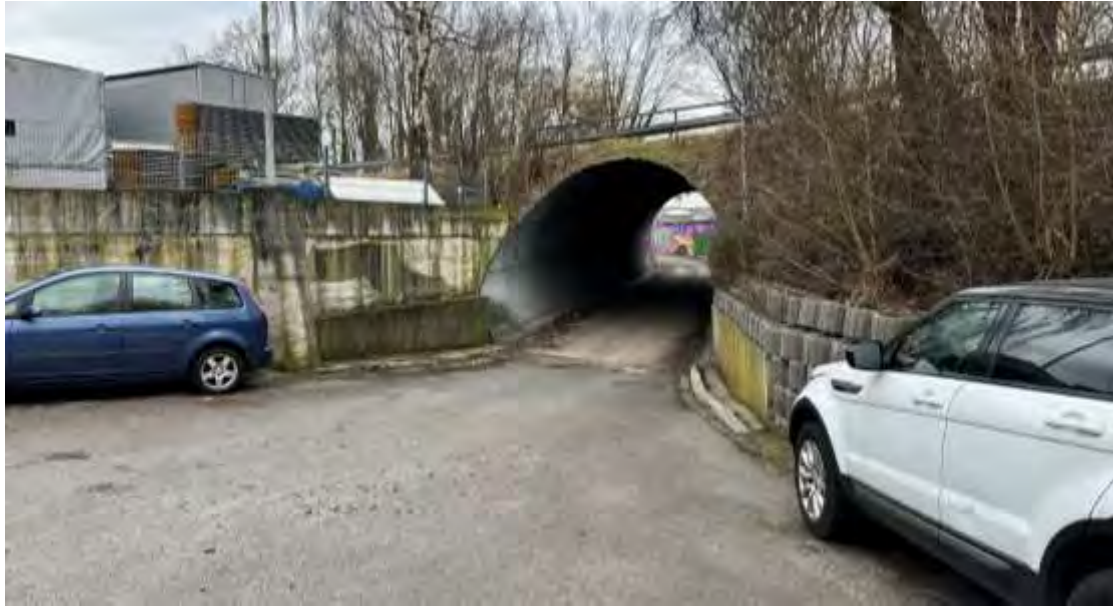
Zu -und Abfahrt durch Tunnel
