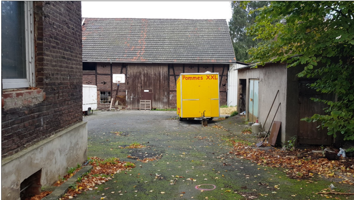
Foto 3: Blick in den Innenhof (Blickrichtung: Nord)
