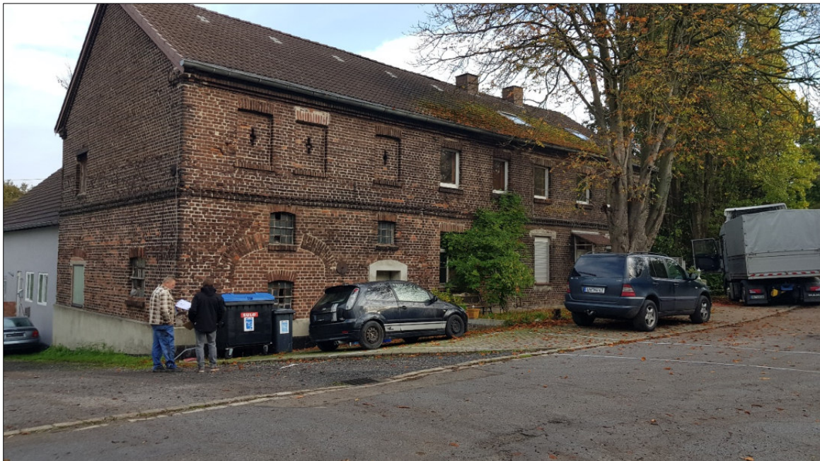
Foto 2: Blick auf die Untersuchungsfläche, Wohnhaus (Blickrichtung: Nord-Ost)
