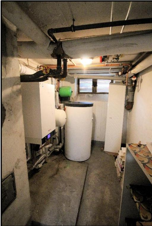
Bild 23: Gas-Brennwert-Heizungsanlage des
