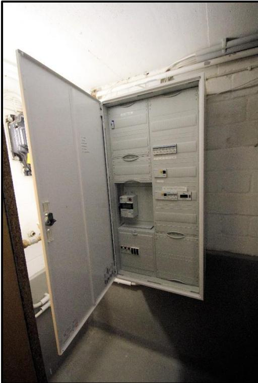
Bild 20: erneuerter Sicherungskasten des
