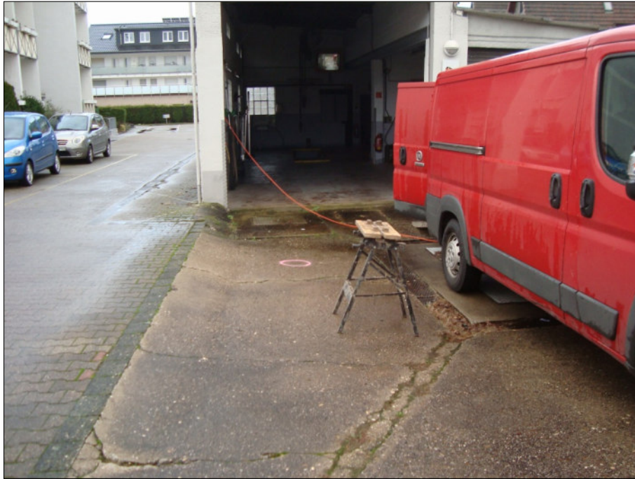
Foto 1: Blick auf den Tankbereich und die Wartungshalle
