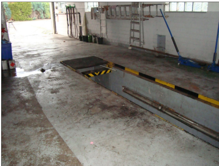
Foto 4: Blick auf den Wartungsbereich in Blickrichtung Eingang
