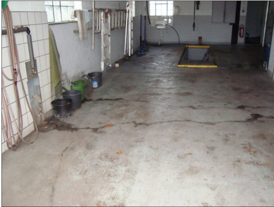
Foto 3: Blick auf den Wartungsbereich vom Eingang
