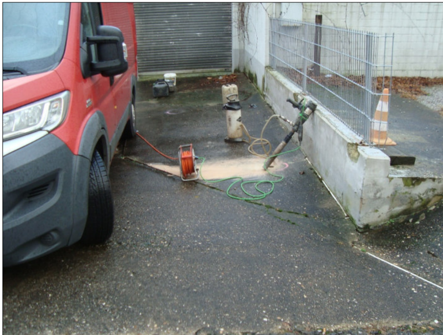
Foto 2: Blick auf den ehem. Tankbereich (Zapfsäule)
