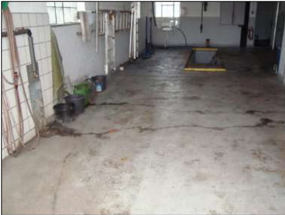
Foto 3: Blick auf den Wartungsbereich vom Eingang
