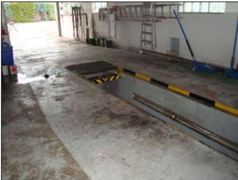
Foto 4: Blick auf den Wartungsbereich in Blickrichtung Eingang
