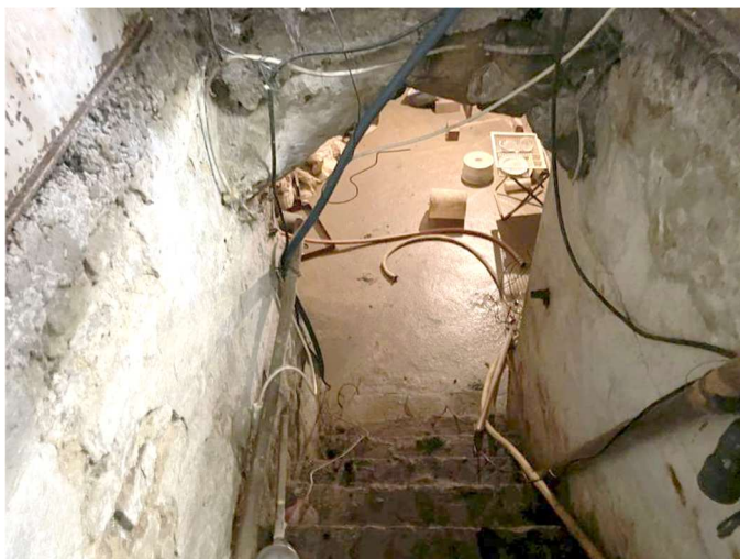
Kellertreppe im Wirtschaftsteil
