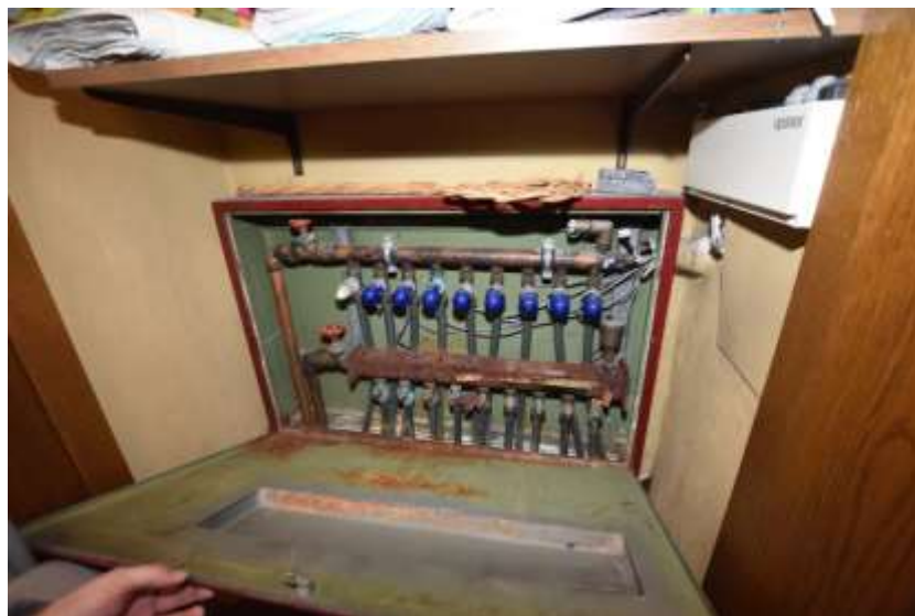
Fußbodenheizung-Heizkreisverteilerkasten
