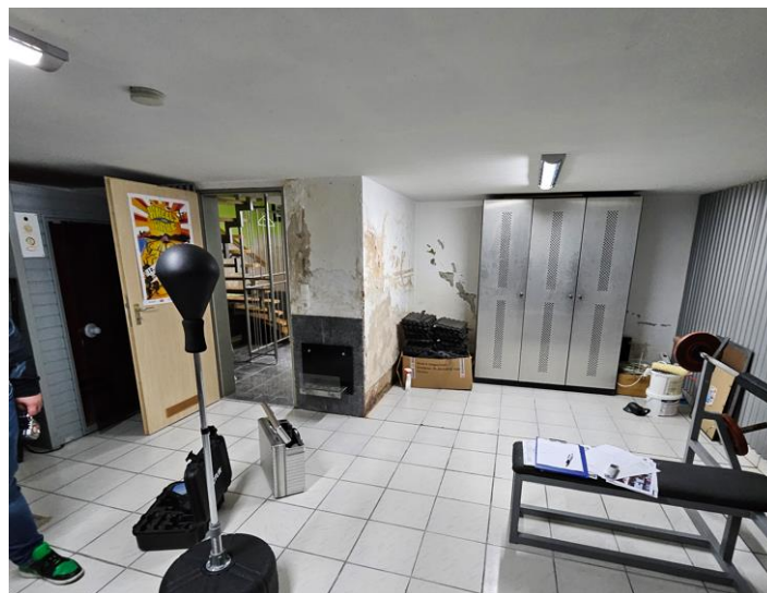
Abbildung 10 - Hobbyraum, Blick auf die Trennwände zum Treppenraum und Duschbadezimmer
