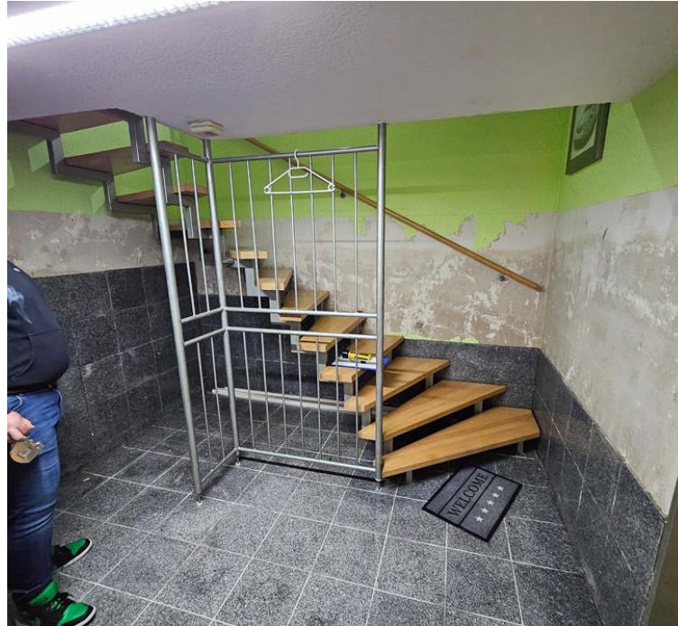
Abbildung 5 - Treppenraum mit Blick auf die Haustrennwand
