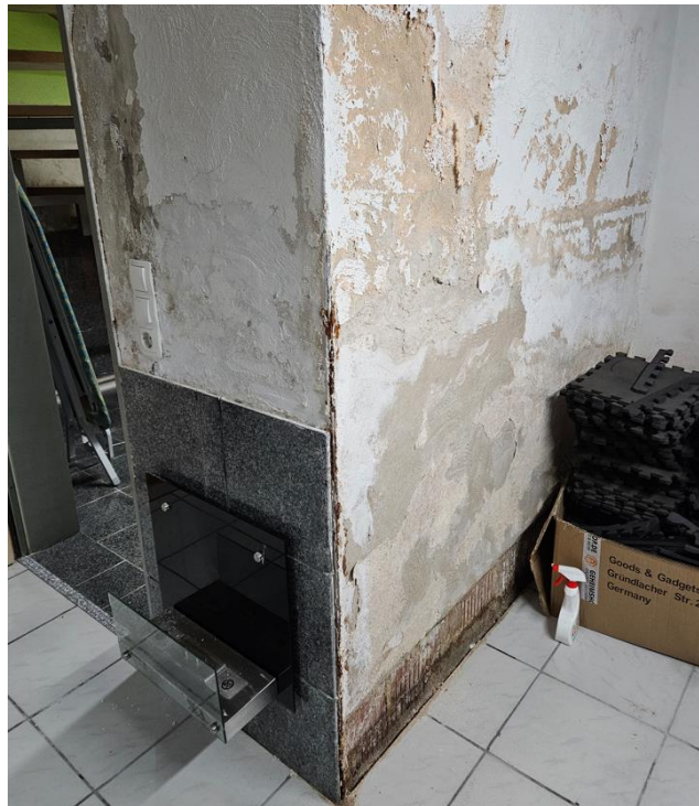
Abbildung 11 - massive Feuchtigkeiterscheinungen
