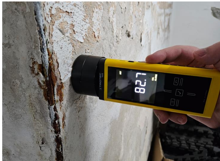
Abbildung 13 - Eckschutzschiene stark korrodiert
