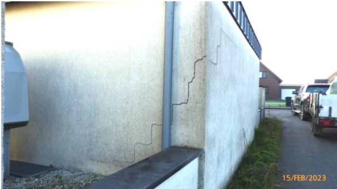
Bild 7: Detailrückansicht der Doppelgarage / Detailaufnahme Gebäuderisse
