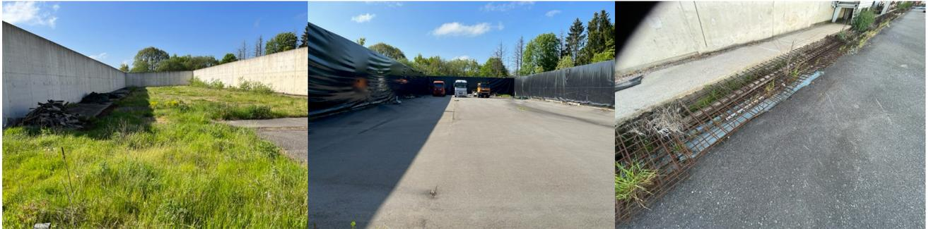
**Links: Silokammer 1 ohne Bodenplatte, Mitte: Silo 2 fertig, rechts Silo 3 und 4 Bodenplatte ohne Deckschicht, ohne Anschluss Dichtfolien und Anschluss Bewehrung zur Wand**
