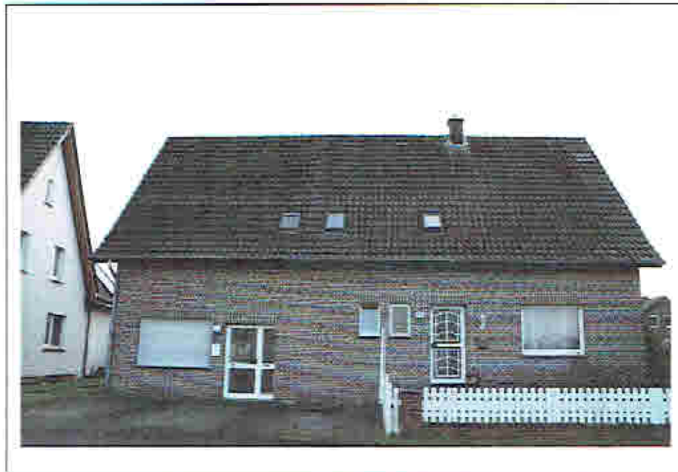
01 Nordwestansicht Langer Schemm
