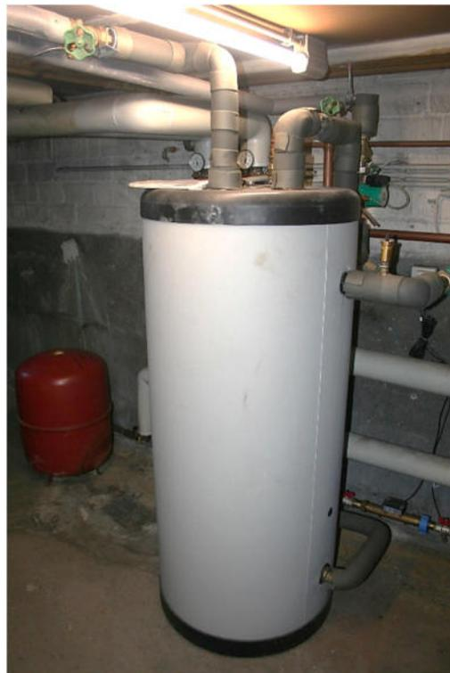
Bild 19: Warmwasserspeicher im KG
