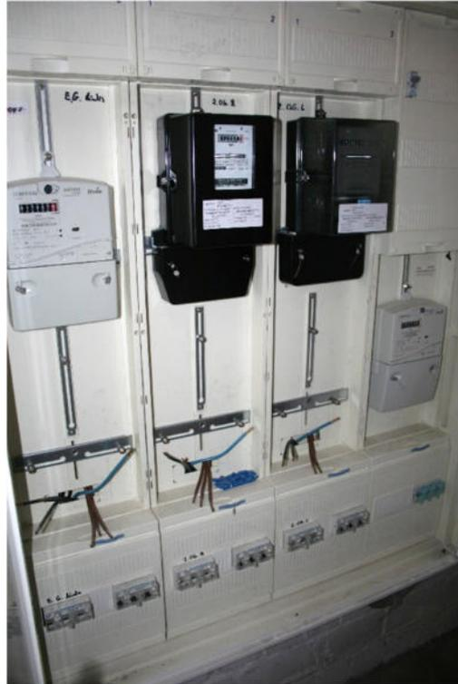
Bild 15: Elektrounterverteilung im KG
