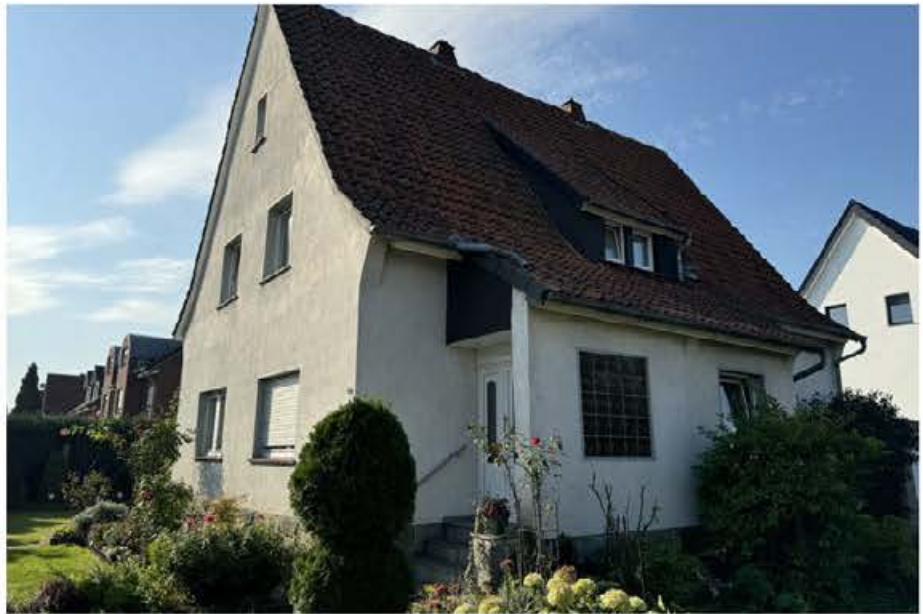
Straßenseite, Ecke „Ringstraße“/ „Mühlenstraße“ Ansicht von c
