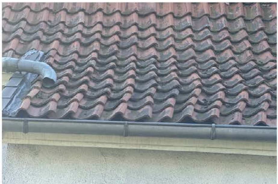
Detail Dach, Nordwestseite
