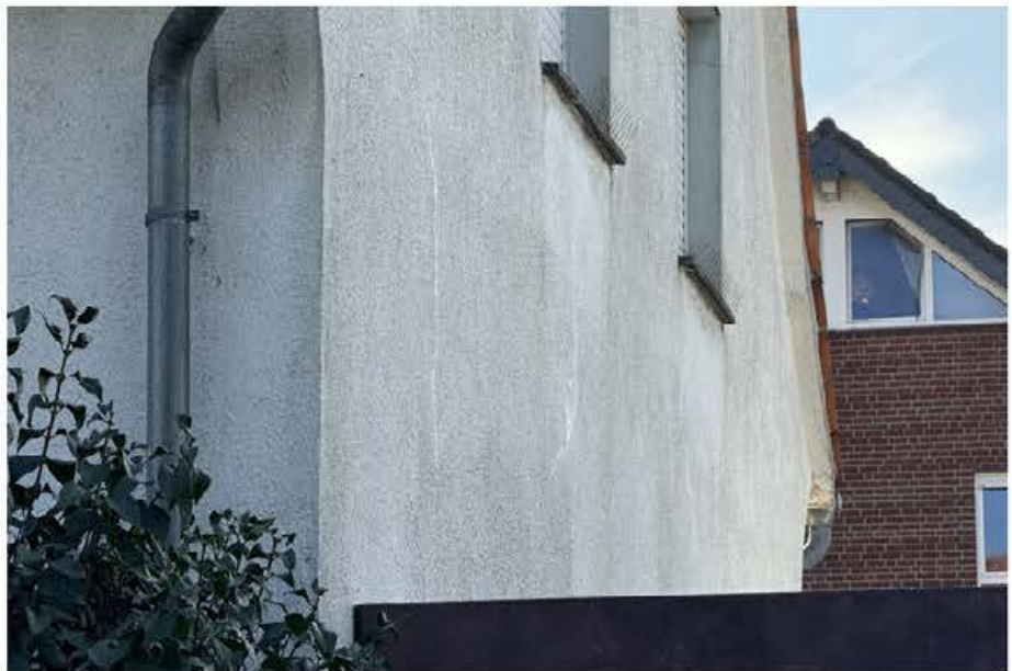
Straßenseite, „Mühlenstraße“ Detail Fassade, Ansicht von Nordwesten
