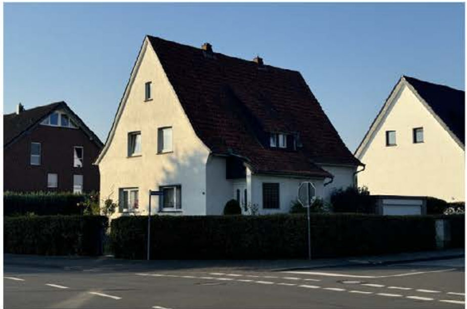
Straßenseite, Ecke „Ringstraße“/ „Mühlenstraße“ Ansicht von Nordosten
