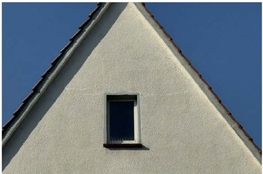
Detail Giebelseite, Nordosten
