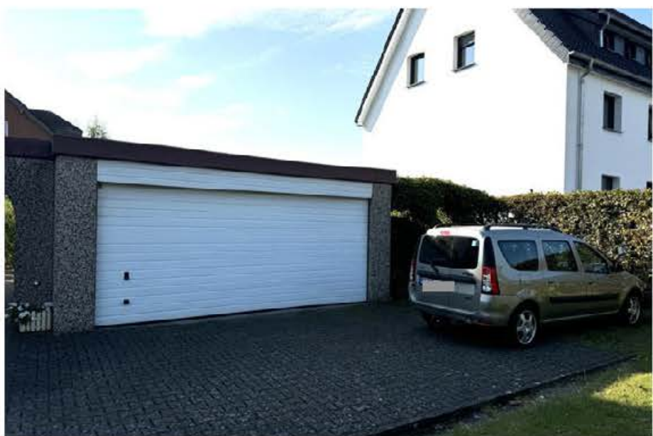
Straßenseite, „Mühlenstraße“ Garage, Ansicht von Norden
