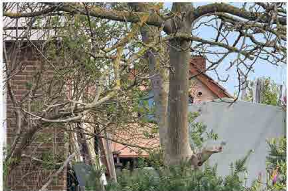
Garage, Ansicht von Südosten
