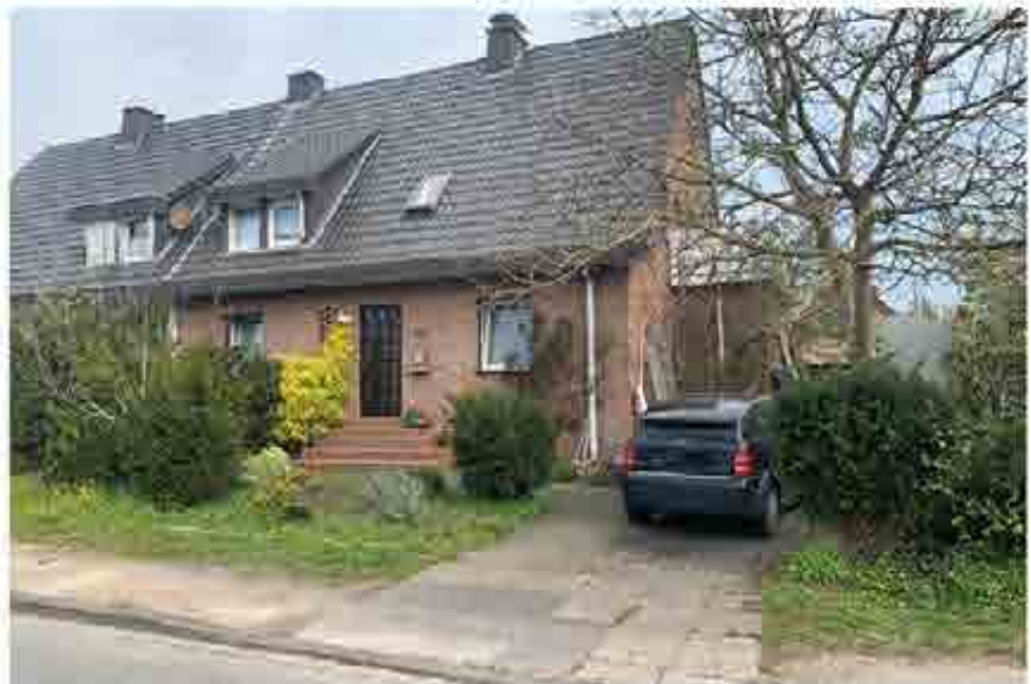
Straßenseite, Ansicht des Objekts von Südosten
