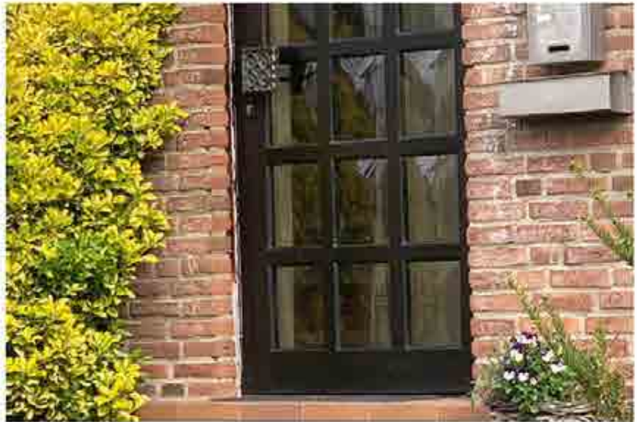
Eingangsbereich, Ansicht von Südosten
