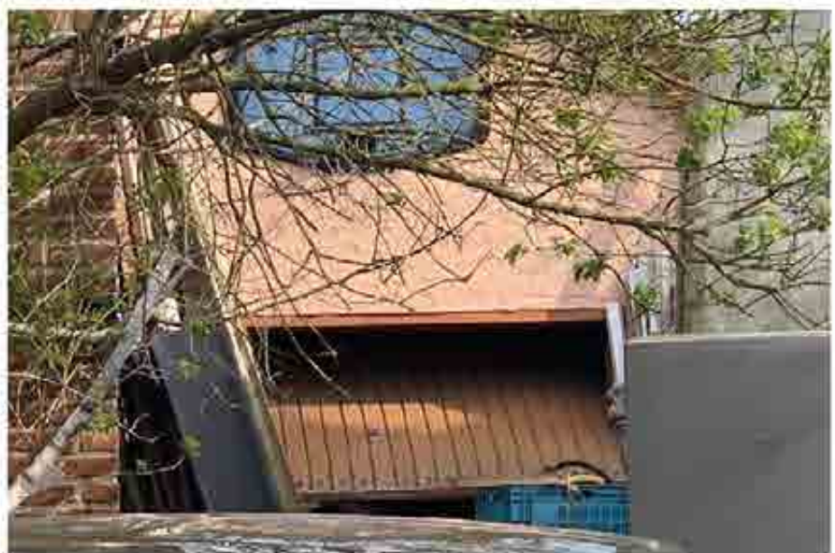
Garage, Ansicht von Südosten
