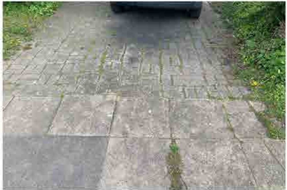
Straßenseite, Zufahrt Garage, Detail Bodenbelag
