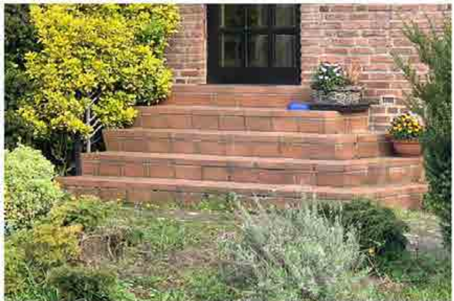
Eingangsbereich, Ansicht von Südosten
