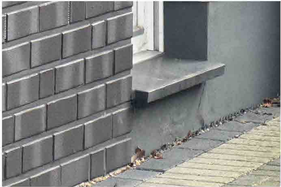
Detail Sockelbereich vor Hauseingang
