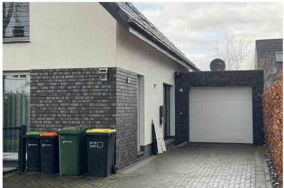
Hauseingangsbereich, Ansicht von Südosten
