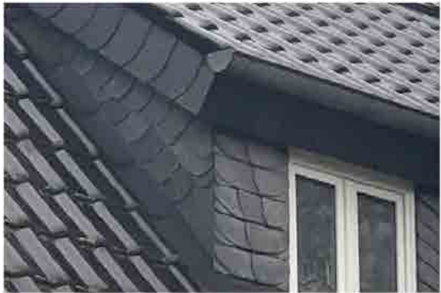
Detail Dach mit Gaube
