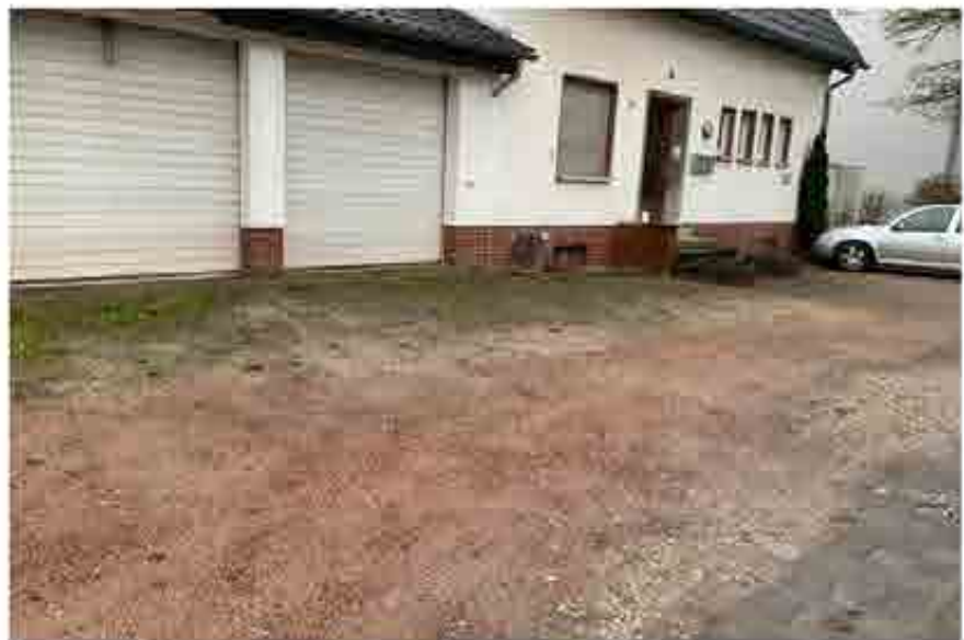
Straßenseite, unbefestigte Zufahrt zur Garage
