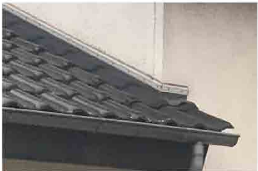
Detail Anschluss Dach / Garage
