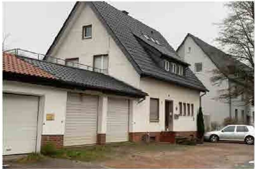
Straßenseite, Ansicht von Südosten
