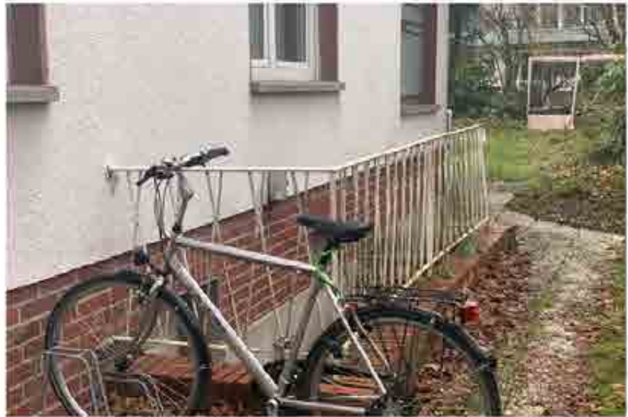
Kelleraußentreppe auf der Nordseite des Objektes
