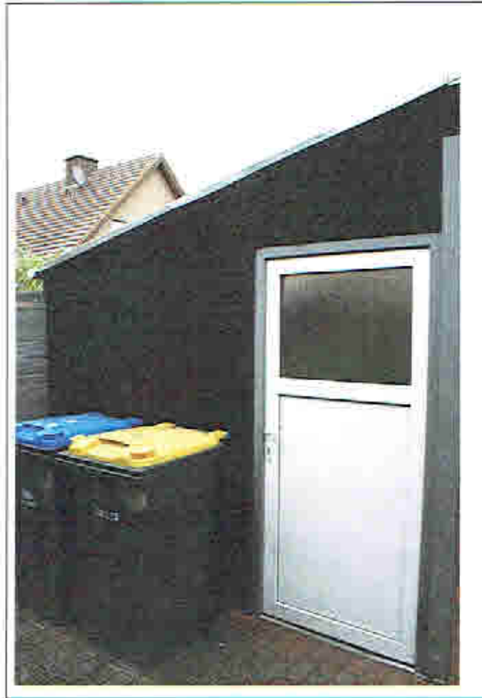
28 Westansicht Anbau Abstellen
