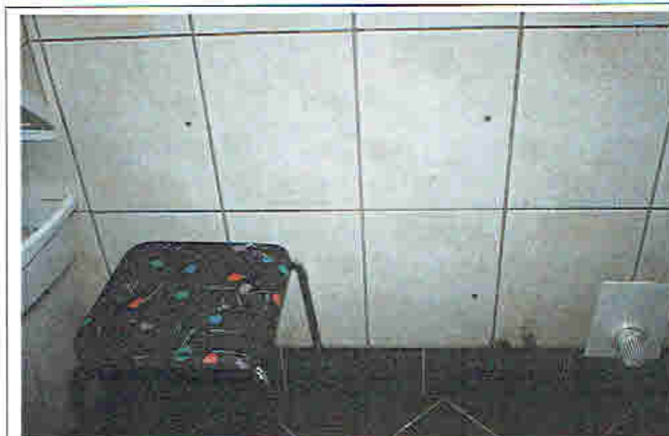
22 Bad demonzierter Heizkörper
