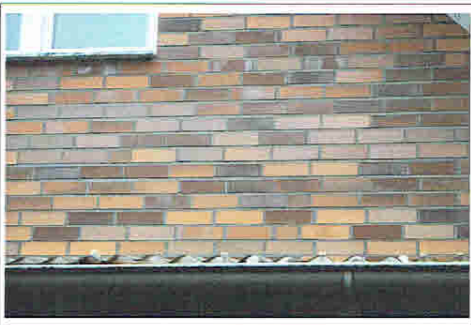
06 Nordansicht Detail Dacheindeckung Schuppen
