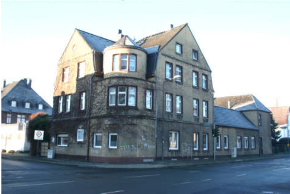
Bild 3: Straßenansicht Borhagener Straße / Ecke Römerstraße / Südostansicht und Nordostansicht
