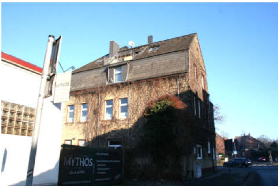
Bild 10: Straßenansicht Borhagener Str. / Südwestansicht / Südostgiebel
