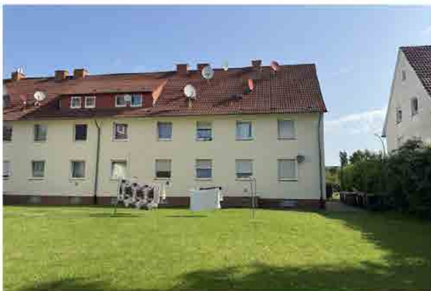
Standort Flurstück 457 , Gartenseite, Blick zu den Flurstücken 433 + 432 ( Wieksweg Hausnr. 15,17 ) Richtung Nordosten
