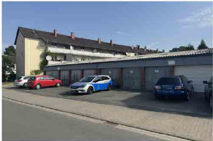
Fritz-Burmann-Straße , Garagen auf Flurstück 760, Ansicht von Süden
