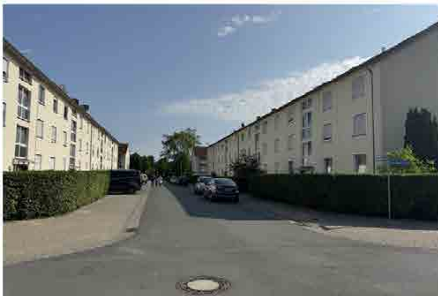
Standort Fritz-Burmann-Straße , Blick in die Vogelsangstraße Richtung Nordosten
