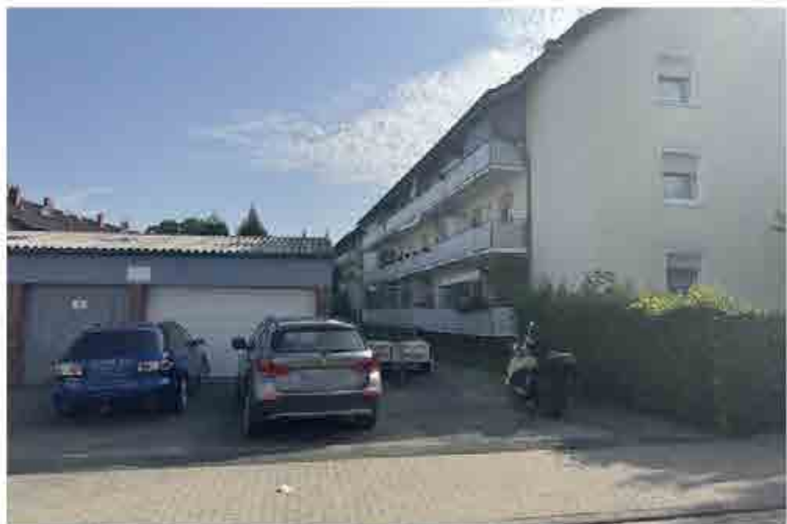
Fritz-Burmann-Straße , Garagen auf Flurstück 760 mit Wohnblock Vogelsangstraße 2-8 , Ansicht von Südwesten
