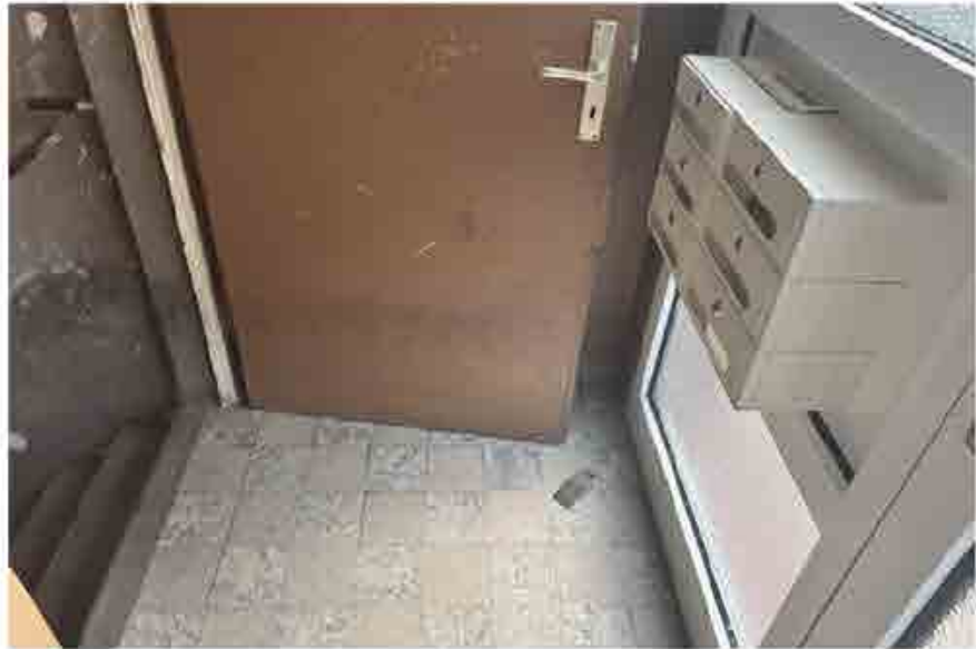
Vogelsangstraße 4, Treppenhaus, Zugang zum Kellergeschoss
