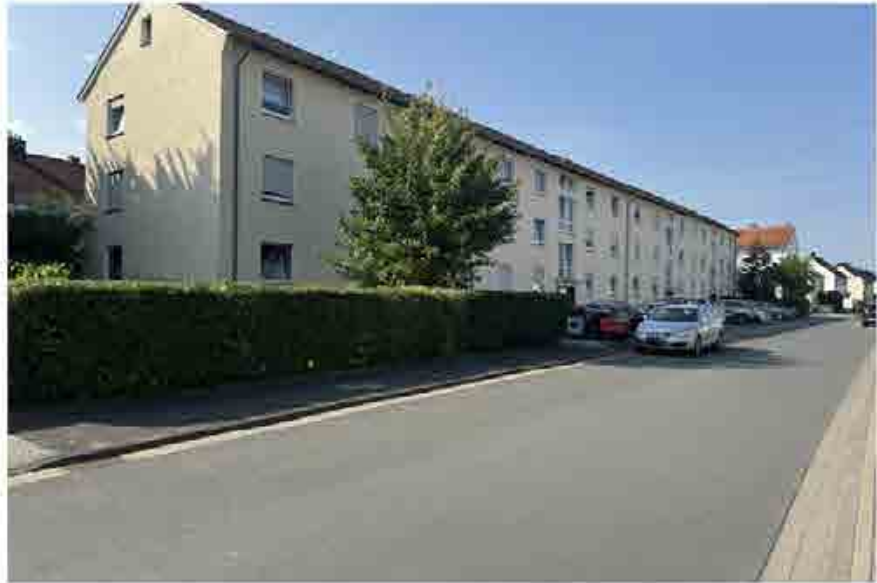
Wohnblock Schmiedestraße 1-7, Ansicht Nordwestseite
