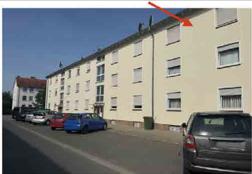
Wohnblock Vogelsangstraße 2-8, Ansicht Südostseite
