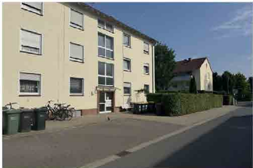
Wohnblock Vogelsangstraße 2-8, Ansicht Südostseite
