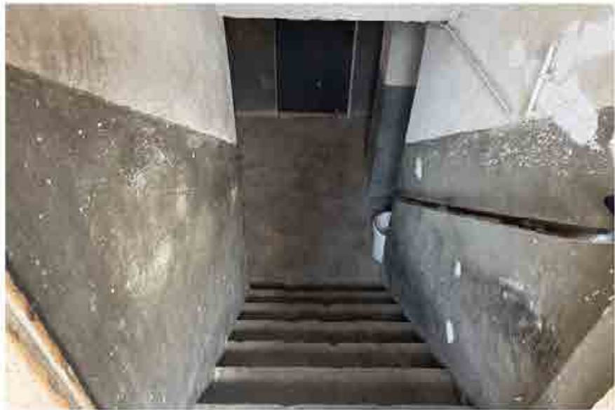
Vogelsangstraße 4, Treppe zum Kellergeschoss
