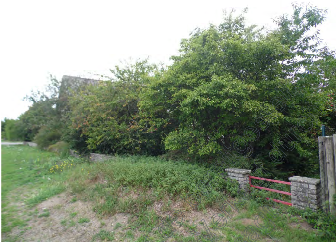
Bild 01: Blick entlang der westlichen Grundstücksgrenze der Bewertungsflurstücke 2/9 sowie 2/3 in Richtung Norden bzw. in Richtung Sandstraße. Mitte links ist das „westliche Ende“ des Wohnhauses mit zwei Wohneinheiten zu sehen.
