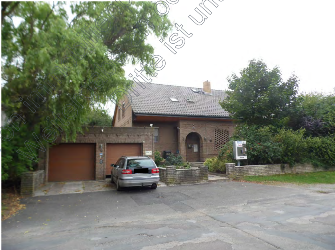
Bild 06: Blick von der Sandstraße auf die Nordseite der Doppelgarage und die nördliche Traufseite (Eingangsseite) des Wohnhauses mit zwei Wohneinheiten .
