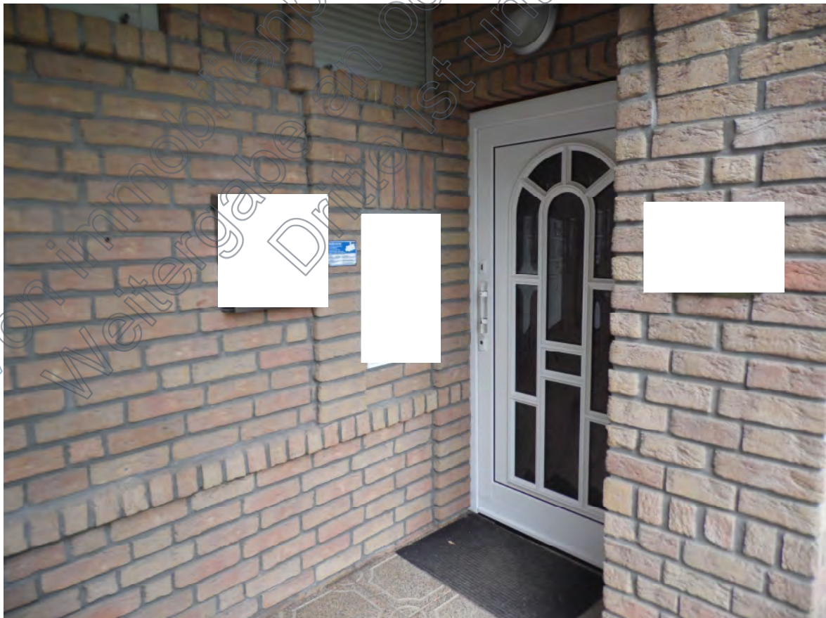
Bild 08: Blick in / durch den Eingangsvorbau auf die geschlossene Hauseingangstür zum Treppenhaus des Wohnhauses mit zwei Wohneinheiten.
