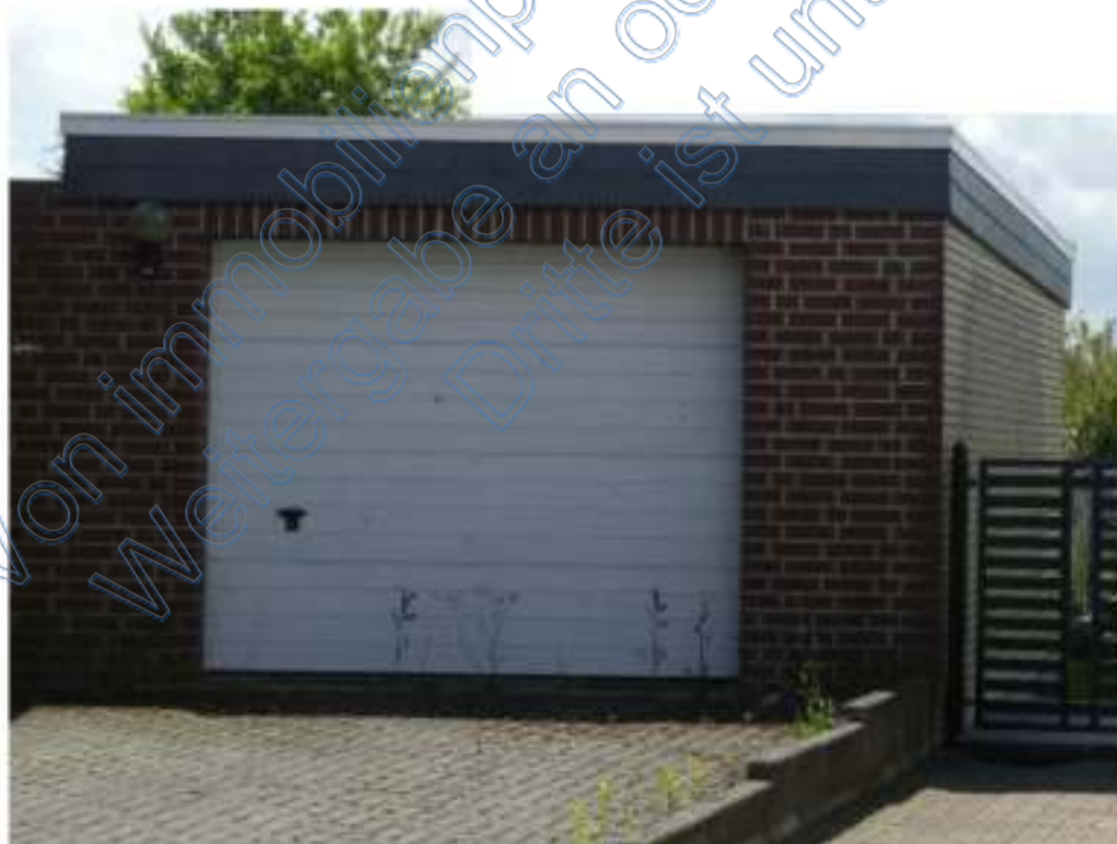
Ansicht auf die Garage
