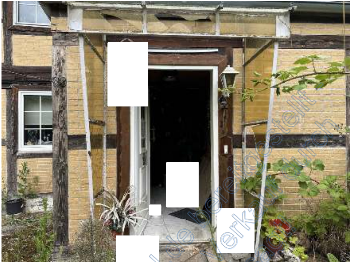
Bild 09: Blick auf und durch die offene Hauseingangstür in den Eingangsfür des Wohnhausanbaus.
