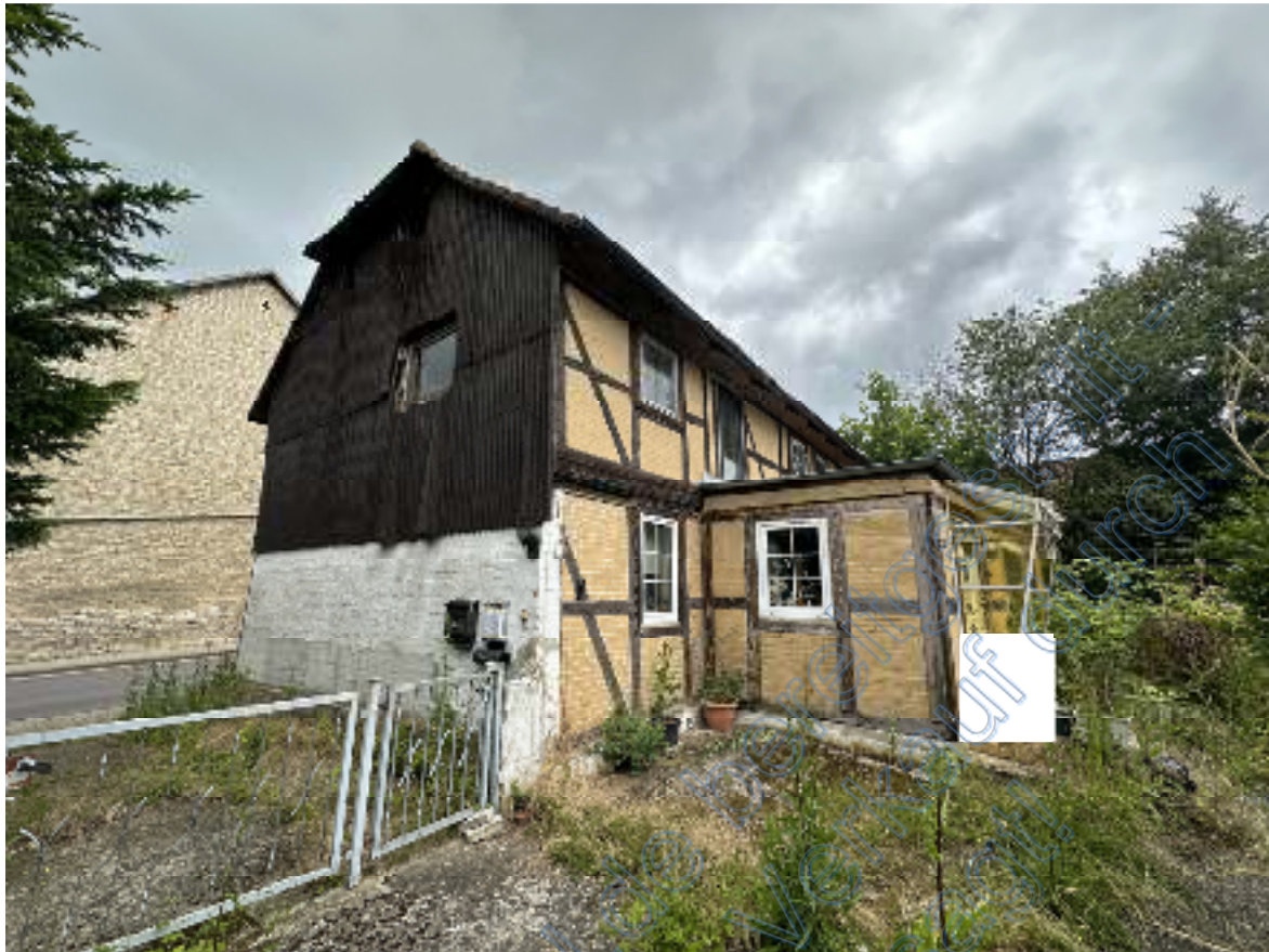
Bild 05: Blick auf die westliche Giebelseite ( links ) und die südliche Traufseite mit anhängigen Wohnhausanbau des Wohnhauses . Ganz links ist die Zugangs- & Zufahrtsfläche in Richtung Berliner Straße zu sehen.
