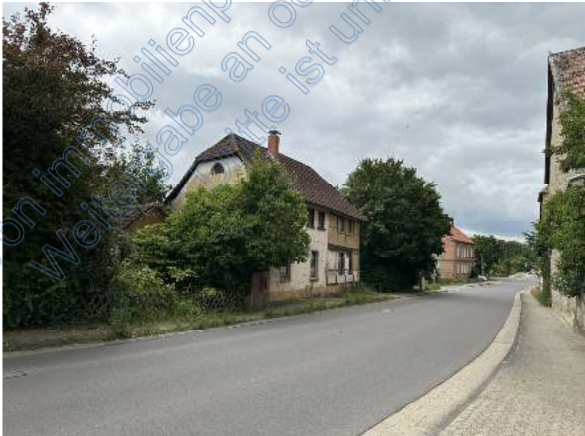
Bild 02: Blick entlang der Berliner Straße in Richtung Westen ( rechts ). Mittig ist das Wohnhaus des Bewertungsobjektes zu sehen. Links davon ist das ( wahrscheinlich als Öllager genutzte )
