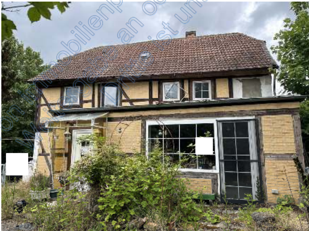
Bild 06: Blick auf und über die Südseite des anhängigen Wohnhausanbaus ( links mit Hauseingangstür) auf die südliche Traufseite des Wohnhauses .
