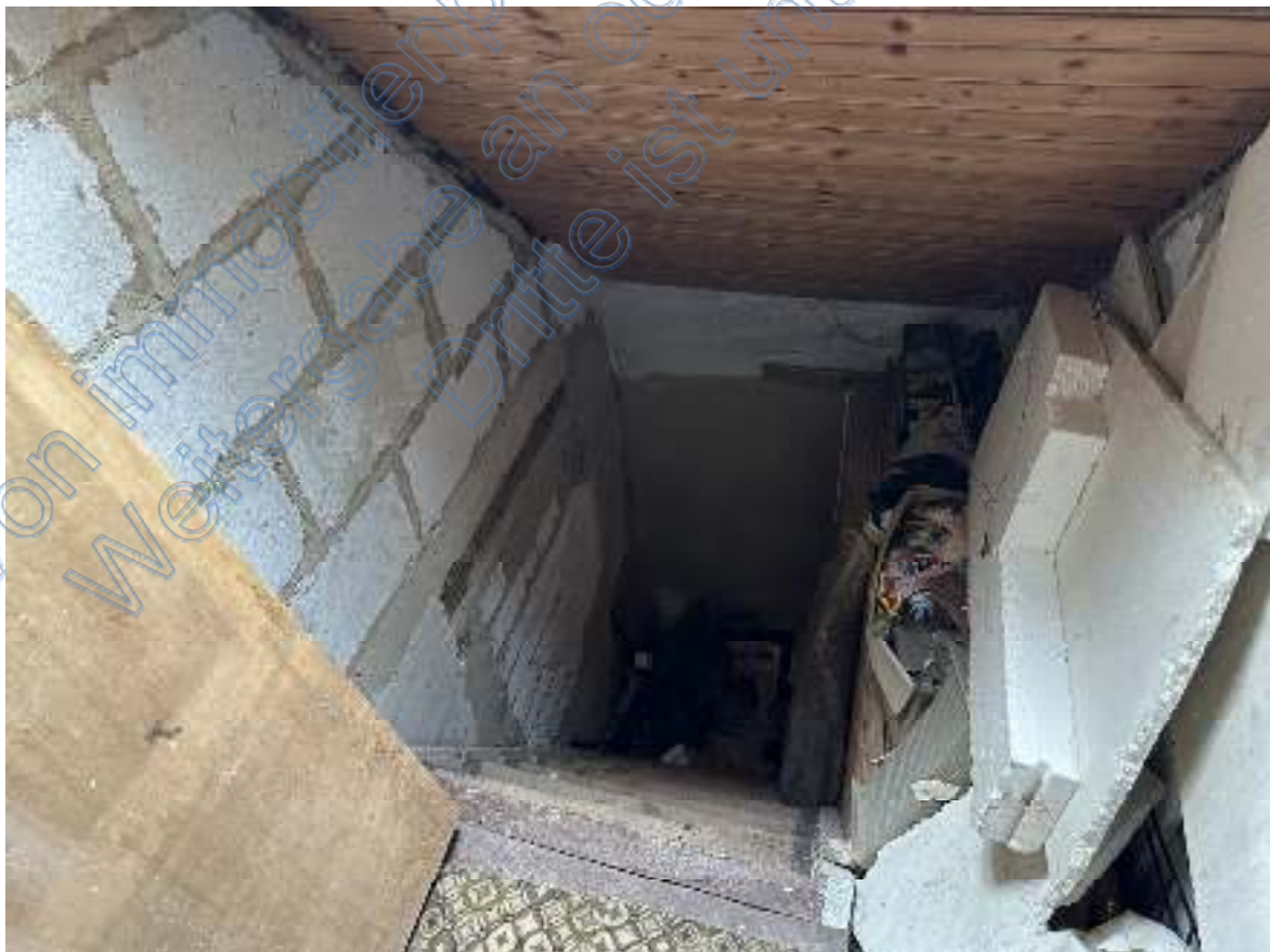
Bild 34: Ausschnitt – Treppenstiege Richtung Flur im Obergeschoss ( Wohnhaus DG Richtung OG ).
