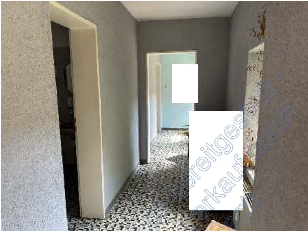
Bild 09: Ausschnitt – Toilettenflur links mit offener Tür zur Damentoilette (Sanitäranbau Gastronomieeinheit EG).
