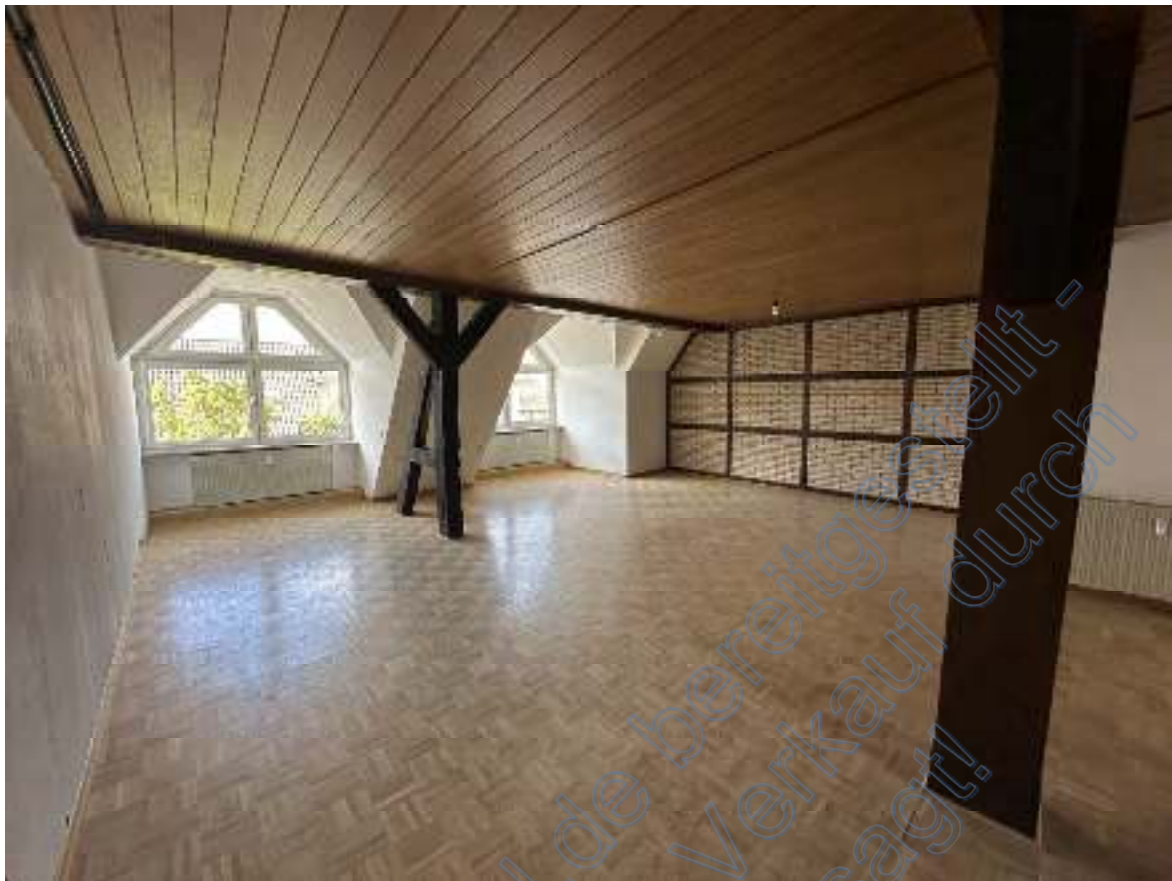
Bild 60: Ausschnitt – Wohnen Richtung Gauben zur Marktstraße (Wohn- und Geschäftshaus Wohnung Nr. 3 DG).
