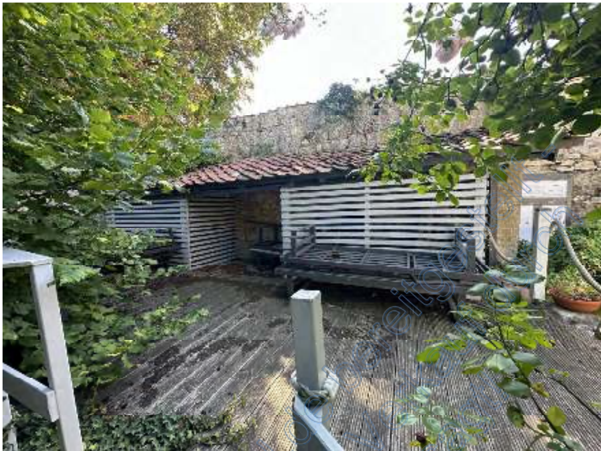
Bild 19: Blick auf die erhöhte „Holzterrasse“ in der Südostecke des Bewertungsflurstücks 340.
