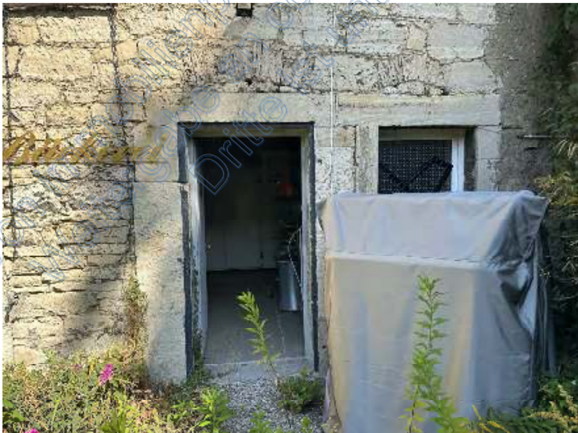
Bild 22: Blick auf die offene Tür zum Vorraum im Konditoreianbau.
