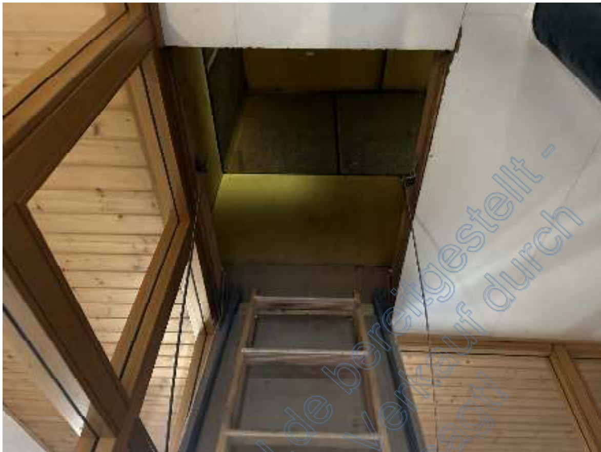
Bild 66: Ausschnitt – Einschubtreppe zum „unteren“ Spitzbodengeschoss ( Wohn- und Geschäftshaus DG Richtung uSBG).
