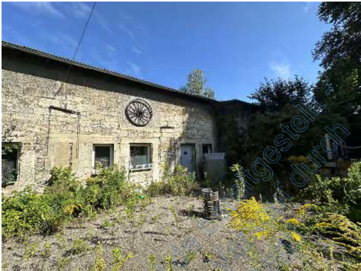
Bild 21: Blick vom Gastronomie-Außenbereich auf die Südseite des Sanitär- & Konditoreianbaus. Mittig ist die geschlossene Tür zum Konditoreianbau zu sehen.
