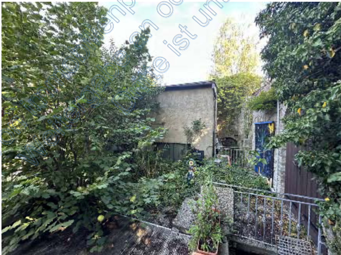
Bild 20: Blick von der erhöhten „Holzterrasse“ auf die Südostecke des Konditoreianbaus.
