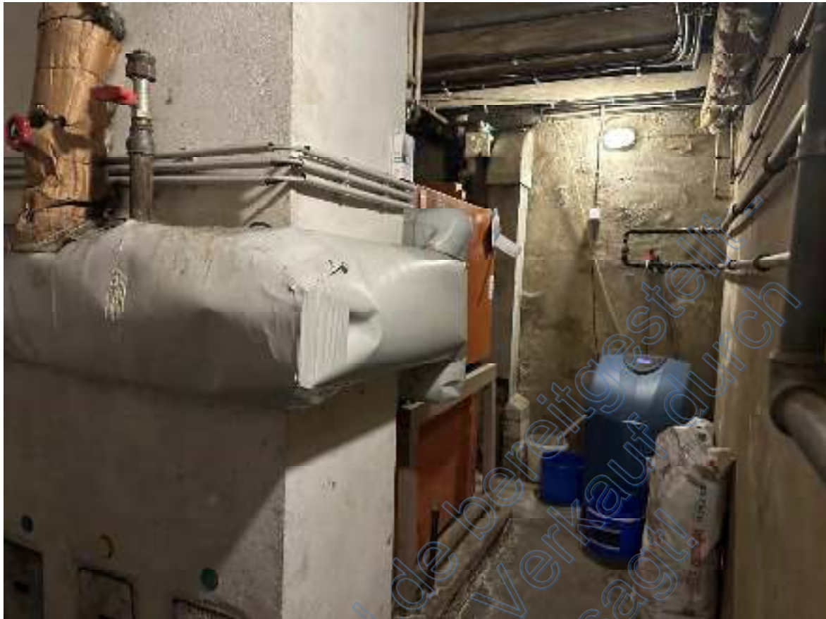
Bild 37: Ausschnitt – Kellerraum 2 / Heizungskeller (Wohn- und Geschäftshaus KG).
