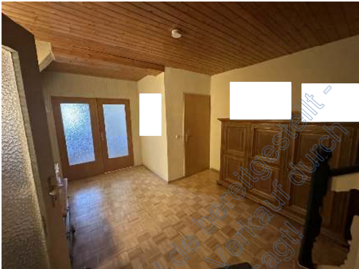
Bild 45: Ausschnitt – Diele Richtung geschlossener Türen zum Sozialraum & Büro der Gastronomieeinheit (Wohn- und Geschäftshaus OG).
