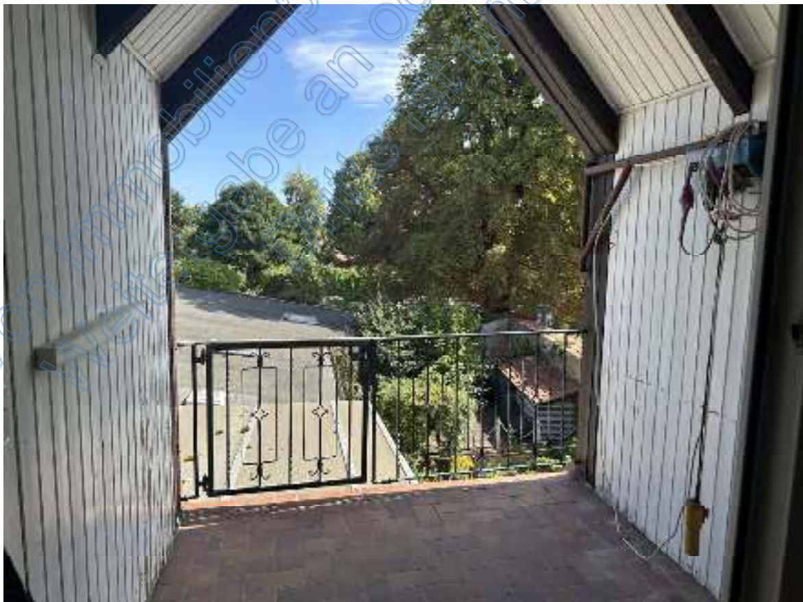
Bild 63: Ausschnitt – Balkon (Wohn- und Geschäftshaus Wohnung Nr. 3 DG).
