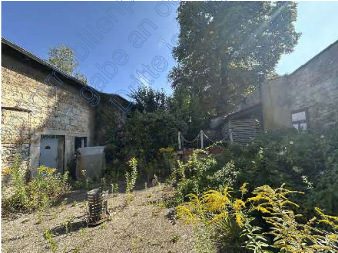
Bild 18: Blick vom Gastronomie-Außenbereich auf die erhöhte „Holzterrasse“. Links ist ein Teil der Südseite des rückwärtigen Konditoreianbaus zu sehen.
