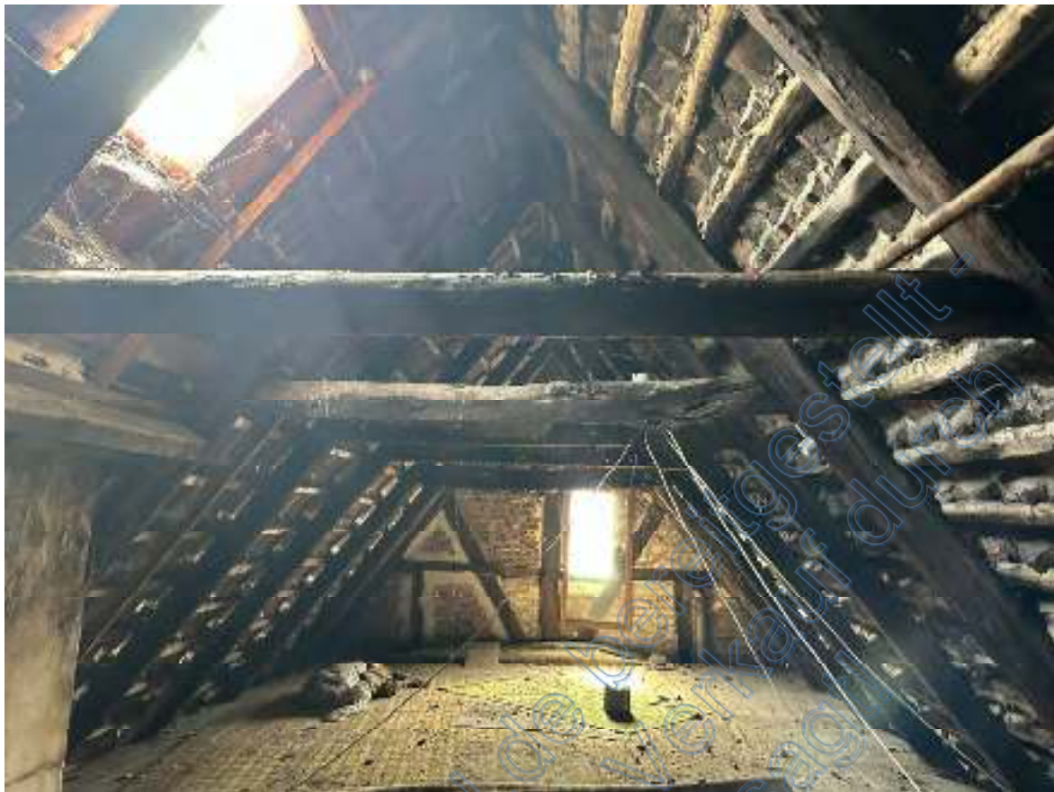
Bild 68: Ausschnitt – „oberes“ Spitzbodengeschoss Richtung Nordgiebel ( Wohn- und Geschäftshaus DG Richtung oSBG).
