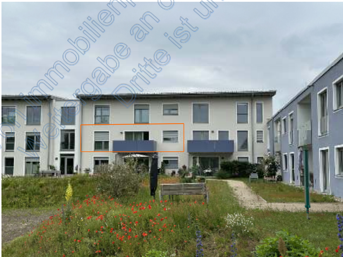
Bild 10: Blick auf die nördliche Ostseite des Mehrgenerationenwohnhauses . Mitte links im Obergeschoss
