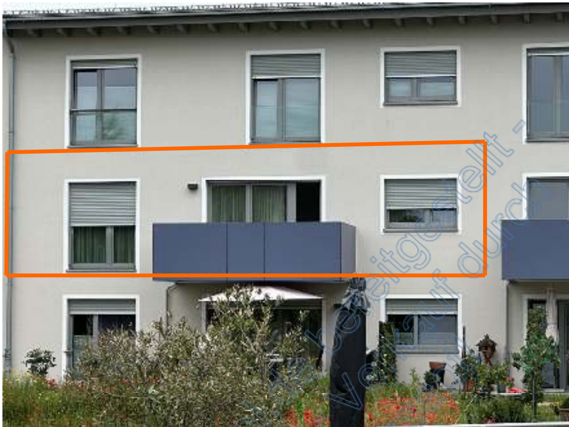
Bild 11: Blick von links auf die Fenstertüren des Schlafzimmers, den Wohnzimmerbalkon sowie das Küchenfenster der Wohnung Nr. 17 .
