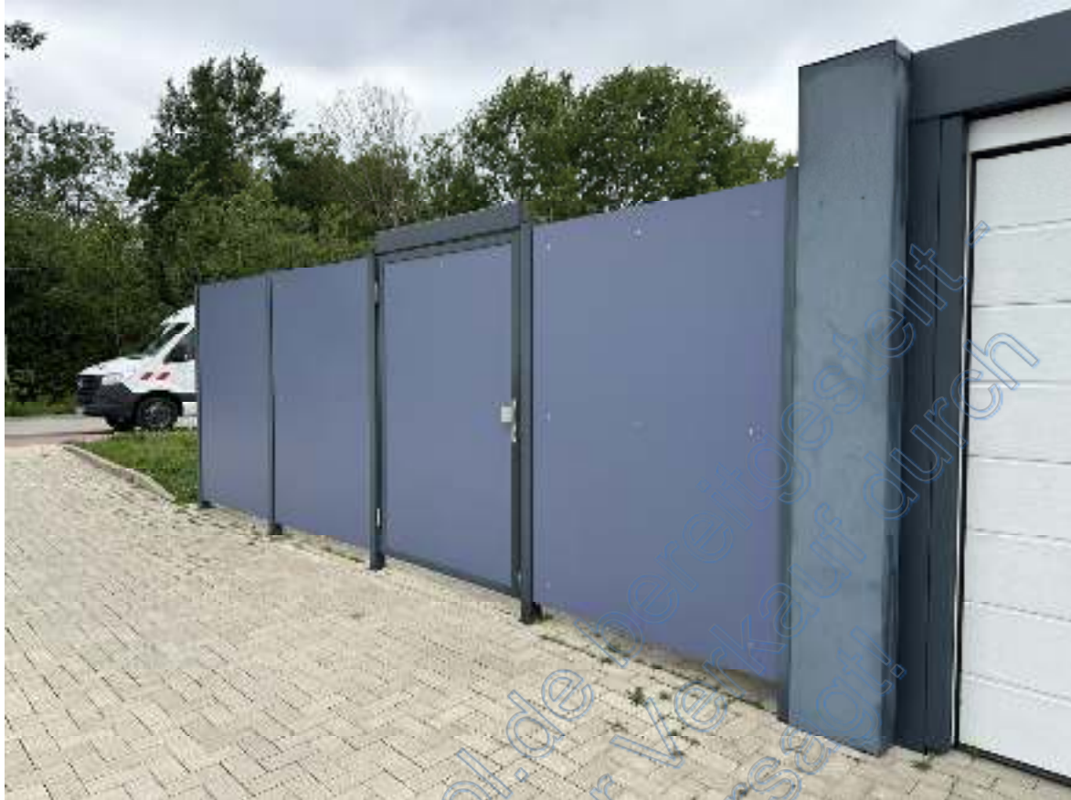
Bild 03: Blick auf die geschlossene Müllplatzeinhausung.
