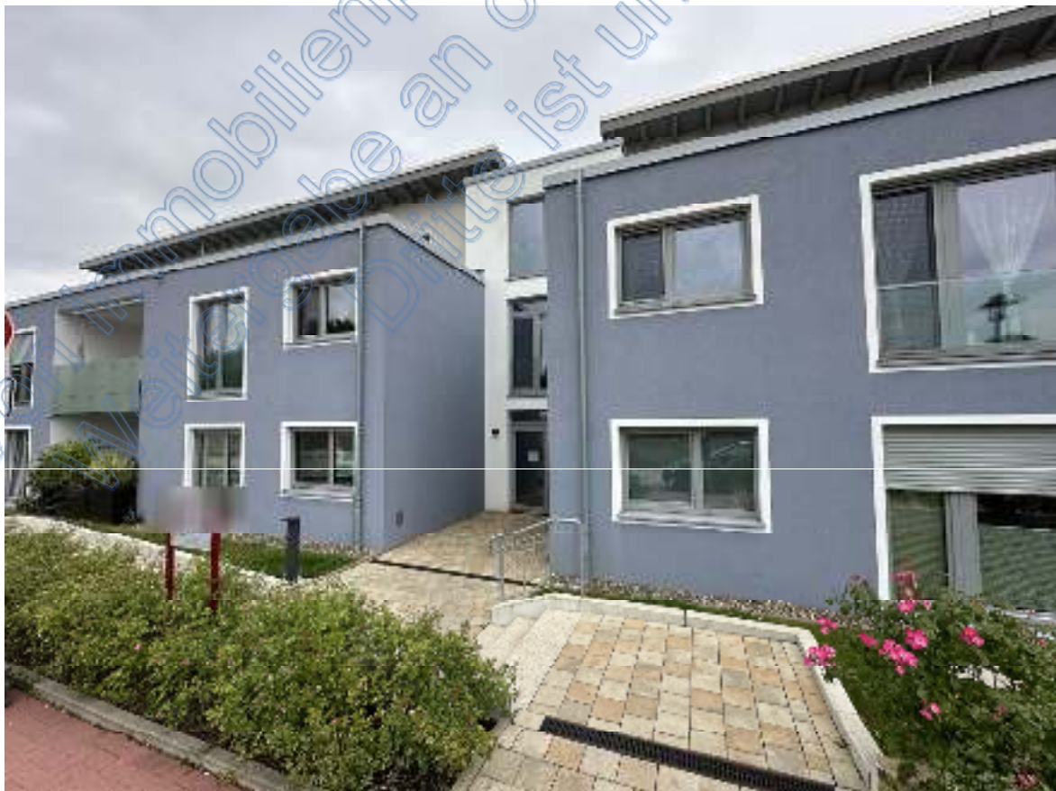
Bild 12: Blick über Zuwegung auf die Eingangssituation (in der Westseite des Mehrgenerationenwohnhauses )
