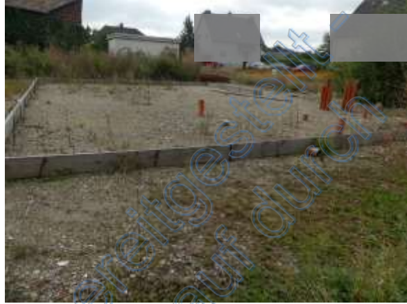
Begonnene Bauarbeiten, Sohlplatte
