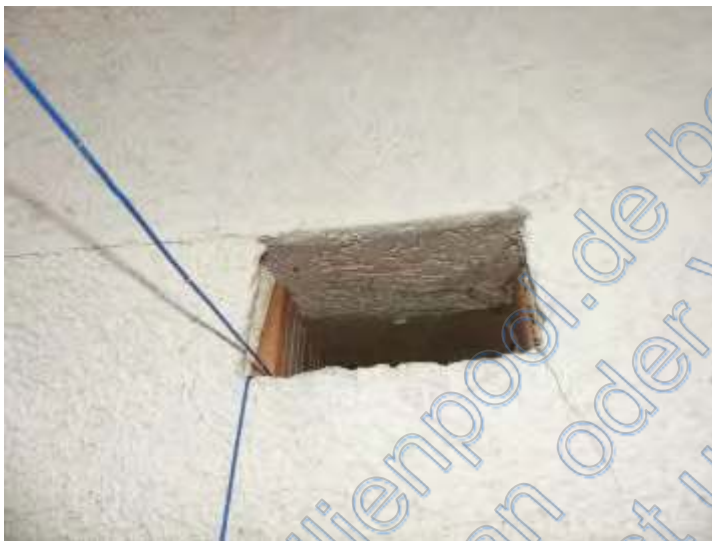
Nicht fachgerecht verschlossen bzw. angearbeitet.
