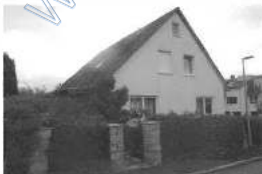
Wohngebäude, straßenseitige Ansicht
