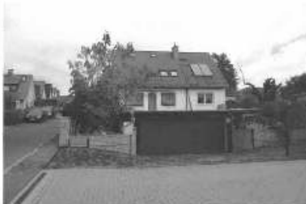
Rückfront mit Garage/ Garagenzufahrt/ -einfahrt
