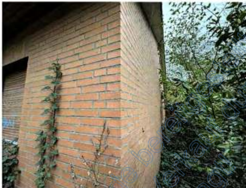
Bild 7: Rückwärtige Giebelseite des Gebäudes Nr. 19c
