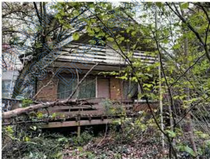
Bild 2: Vorderansicht des Gebäudes 19b
