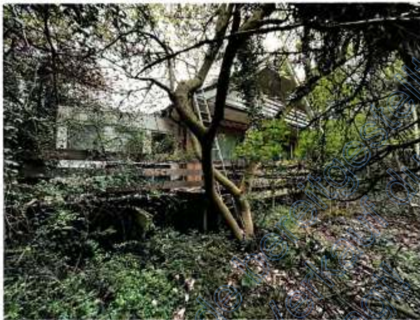
Bild 1: Vorderansicht des Gebäudes 19b
