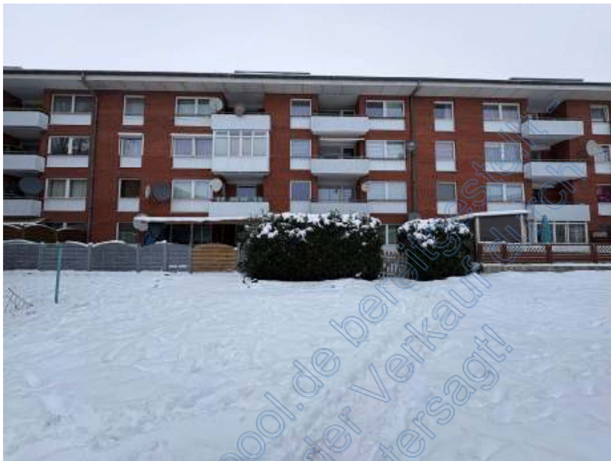
Rückansicht mit Nachbargebäuden
