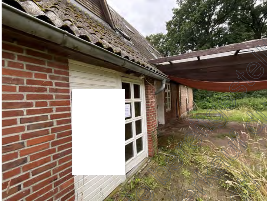
Bild 5: Ansicht des Hauseingangsbereichs des Bewertungsobjekts
