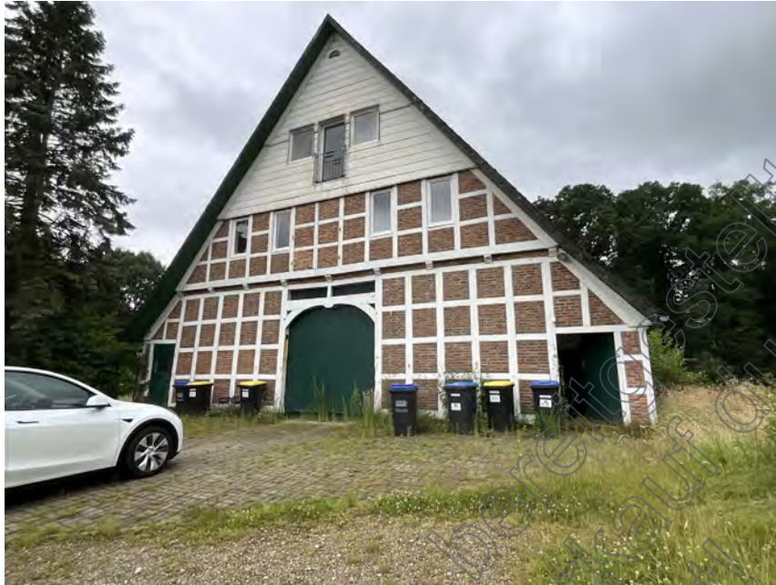
Bild 1: Ansicht des Hauseingangsbereichs des Bewertungsobjekts
