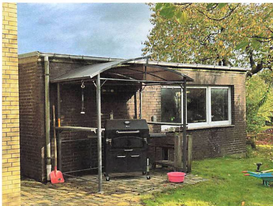
Foto 6: Nebengebäude (Wirtschafts- u. Öltankraum), Südansicht aufgenommen am 21.10.2025
