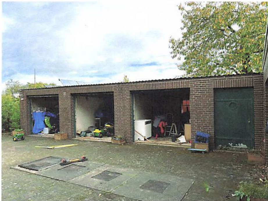
Foto 4: Nebengebäude (Garagen), Westansicht aufgenommen am 21.10.2025
