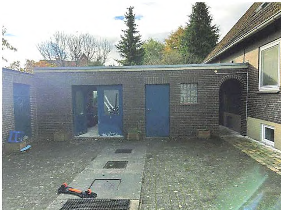
Foto 5: Nebengebäude (Wirtschafts- u. Öltankraum), Nordansicht aufgenommen am 21.10.2025
