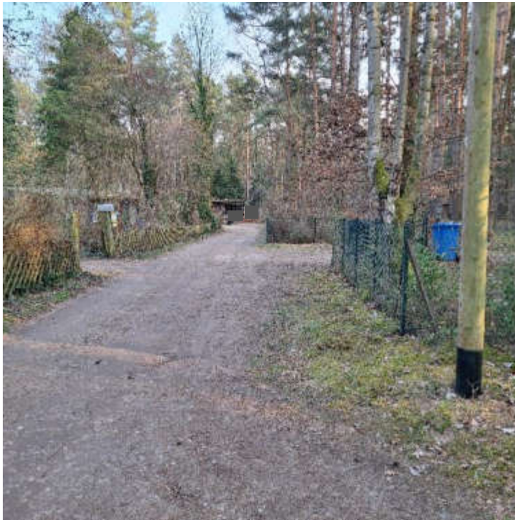
Abbildung 15: beispielhafter Ausbau des Wegenetzes
