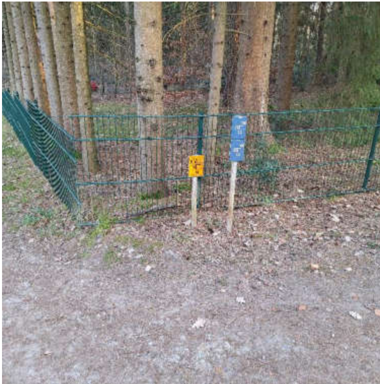
Abbildung 11: Trinkwasser- und Gasanschlüsse liegen vor Ort
